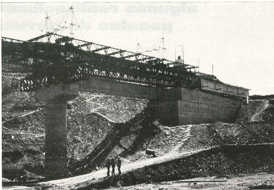
Fig. 2. — Lanzamiento de un tramo.
