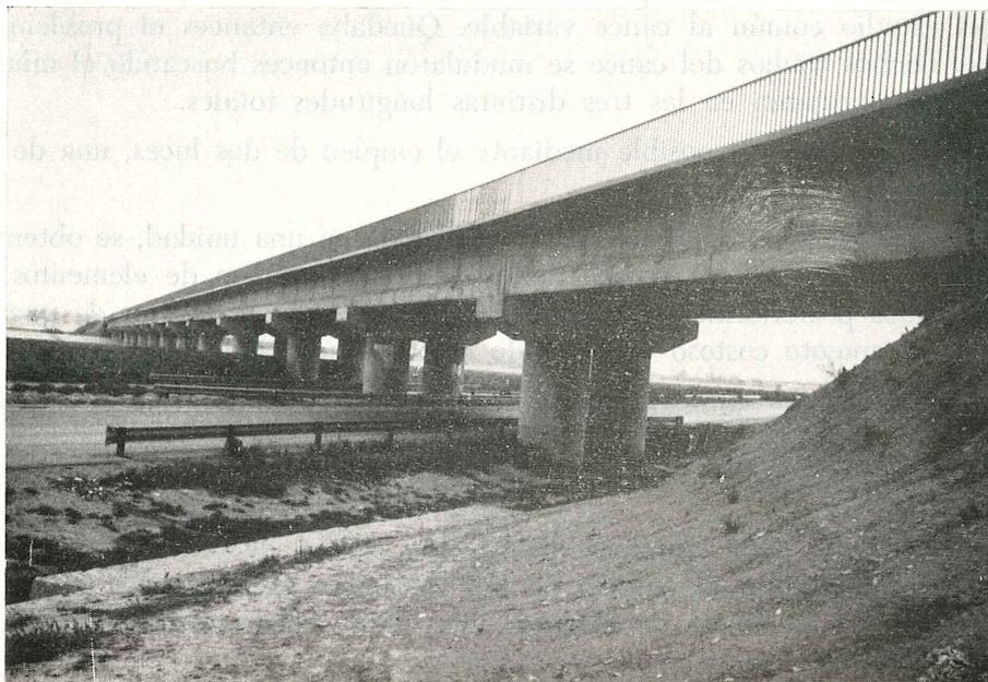
Fig. 7. — Pilas tipificadas del puente de Liria.
