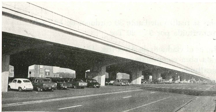
Fig. 40. — Viaducto de Wilrijk
