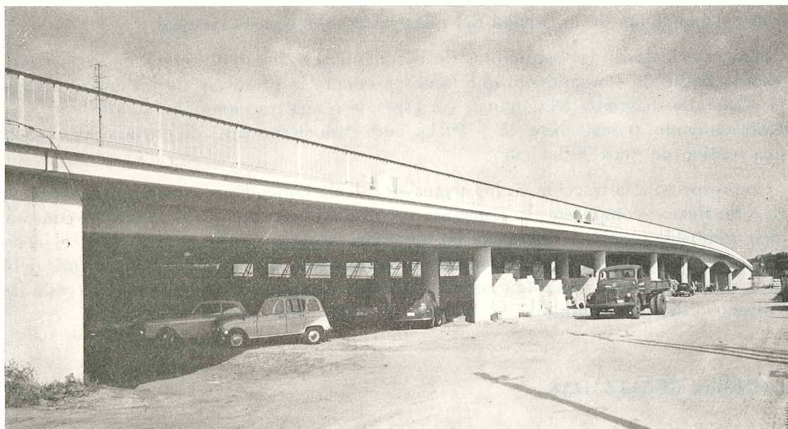
Fig. 2. — Puente de Ravels. Viaducto de acceso.
