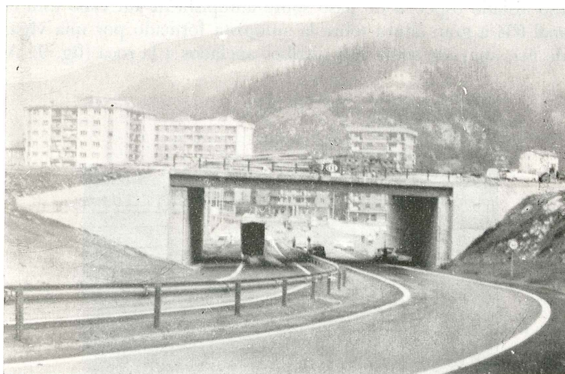
Fig. 11. — Enlace de Ermúa. Losa sobre estribos cerrados.
