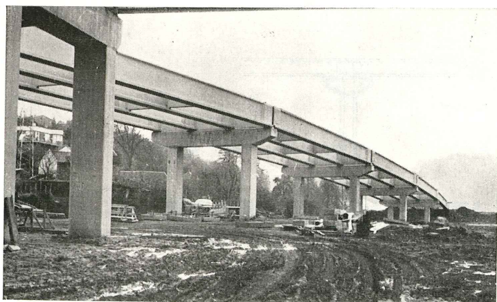
Fig. 53. — Viaducto S2. Rampa de acceso
