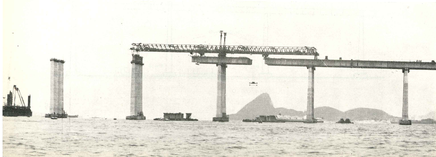
Fig. 10. — Construcción de la parte más elevada del puente mediante dos vigas de lanzamiento.
