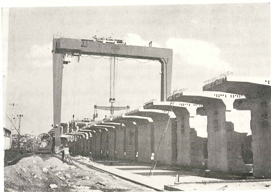
Fig. 8. — Zona de almacenamiento de las dovelas prefabricadas.
