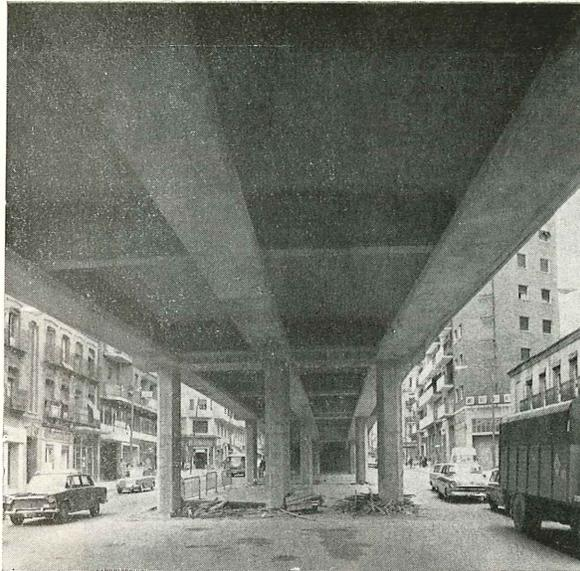
Fig. 1.— Vista interior de los tramos de 20 m y de tres vigas del ramal principal.
