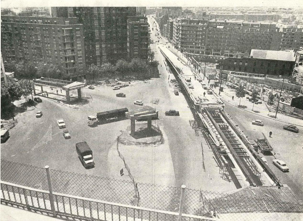
Se abren en un tramo de 35 m en el paso elevado de Capitán Cortés. Véase la colocación de las viguetas del encofrado del tablero, que va a ser soportado por las vigas Preflex sin ningún apeo y conservando el paso de la circulación
