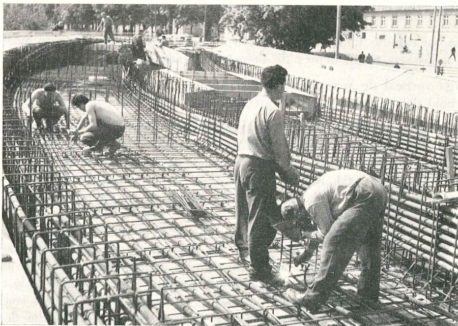
Fig. 9. — Colocación de la armadura en la viga del puente.
