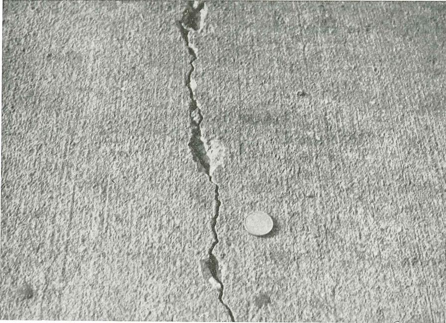
Grieta transversal abierta, desconchada superficialmente, en una losa del sistema fijo.
