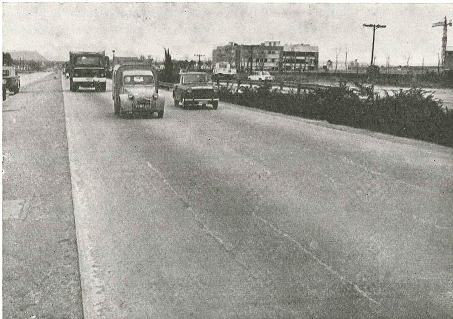
Grietas longitudinales localizadas sobre algunos cables del sistema de pretensado interno.
