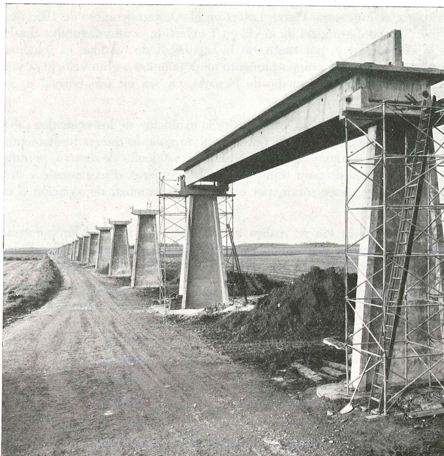
Fig. 3. — La viga en "T" invertida apoya sobre las pilas; está constituida por elementos de hormigón pretensado de 20 metros de longitud.
