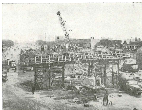
Fig. 26. — Construcción de la pila P1.
