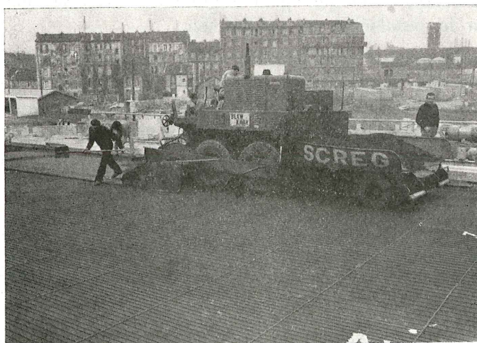
Fig. 110. — Revestimiento de los cables calefactores. Tipo semirremolque.
