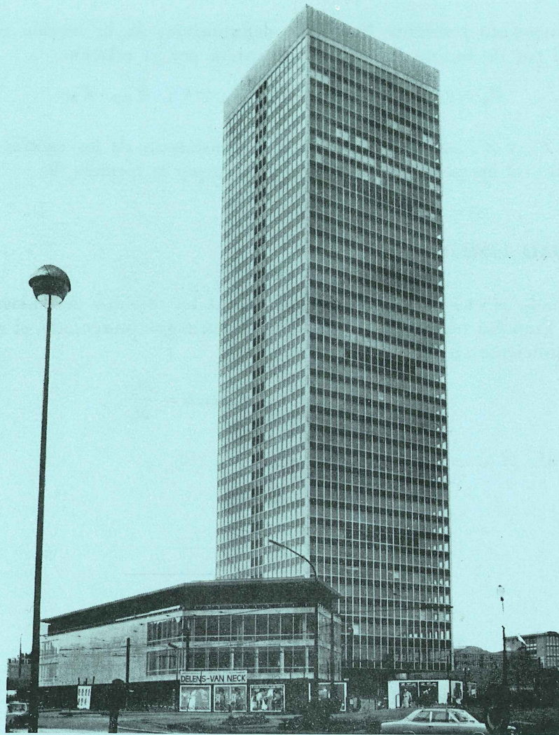
Edificio "Tour du Midi", en Bruselas. Se utilizaron 144 vigas PREFLEX de 40 m de longitud, en la construcción de la torre, y 16 en los edificios anejos.
