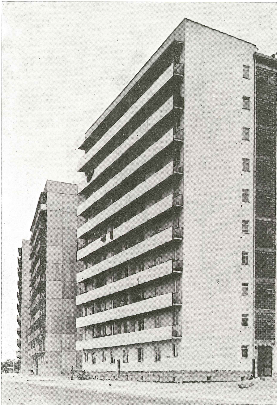
Otro ejemplo más de edificio, construido en Varsovia, utilizando grandes paneles prefabricados de hormigón.
