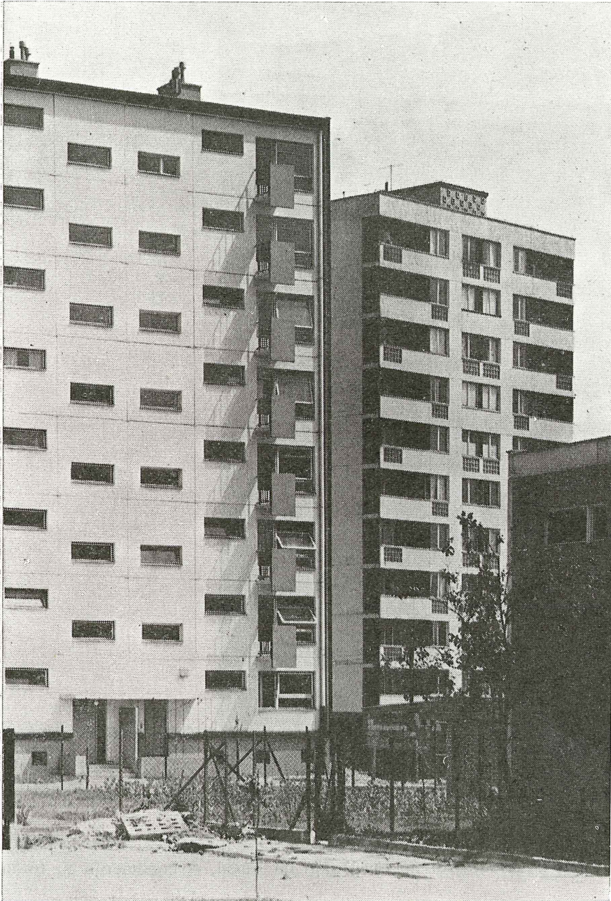
Un segundo ejemplo de edificio, construido en Varsovia, utilizando grandes paneles prefabricados de hormigón.
