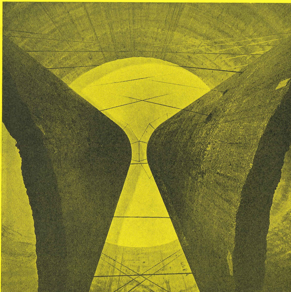
Pabellón de OFICEMEN en la FICOP - 1967: Suspensión de los cilindros de 165 Tm con alambre de \phi 5 mm.
