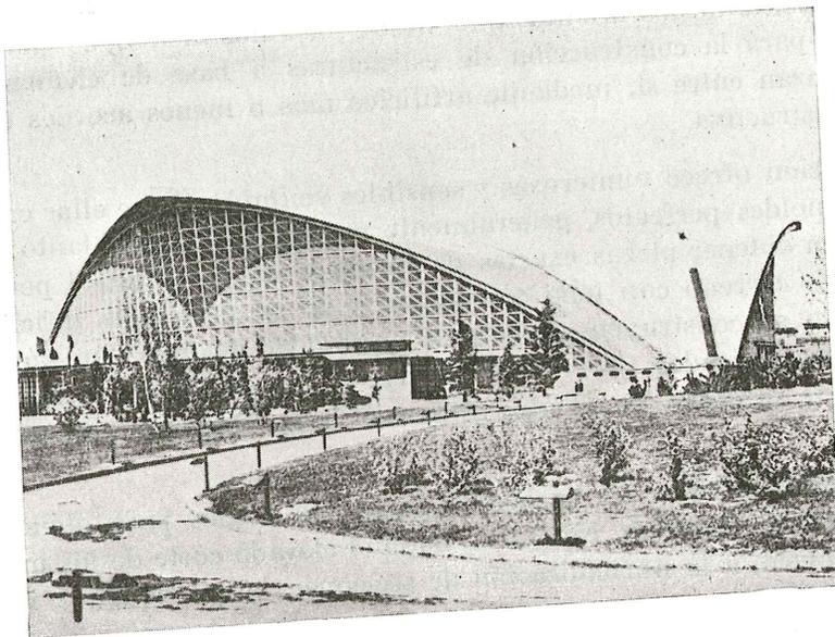
Fig. 12.—Nuevo Palacio de Exposiciones, en Turín: Cada uno de los arcos que constituyen la cubierta funciona como funicular bajo su peso propio.
