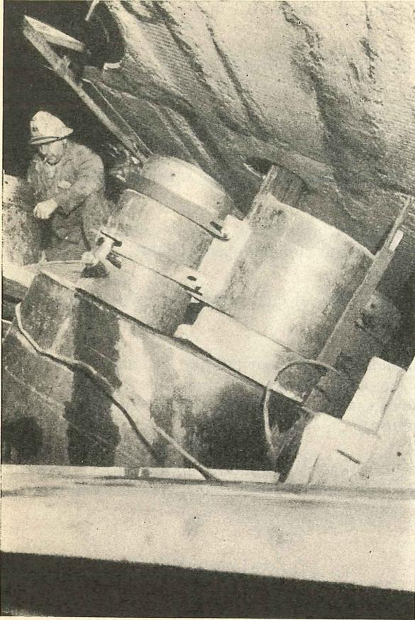
**Pila del reactor de la Central Nuclear de Marcoule (Francia):** Las cabezas de anclaje de los cables longitudinales de pretensado fueron hormigonadas «in situ». Los cables del pretensado circunferencial se apoyan sobre unos patines de fundición que descansan sobre placas, también de fundición, lubricadas. Sus cabezas de anclaje apoyan sobre tres cilindros de hormigón armado. La tensión inicial, de 1.230 toneladas, se introduce mediante tres gatos hidráulicos.
