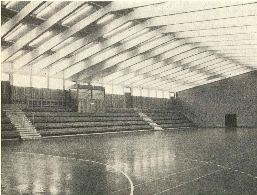
Palacio de deportes, en Bellahj (Copenhague): Las cerchas rígidas de la cubierta tienen 30 m de luz y son prefabricadas y postensadas.
