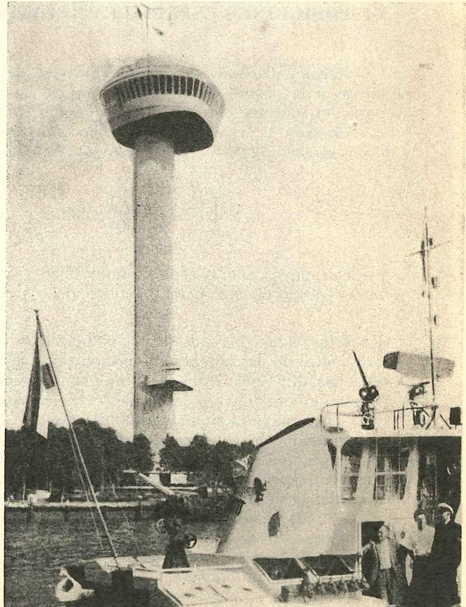
**El «Euromast» de Rotterdam (Holanda):** Por uno de sus lados va pretensado verticalmente, con el fin de compensar el peso ex-céntrico del restaurante.
