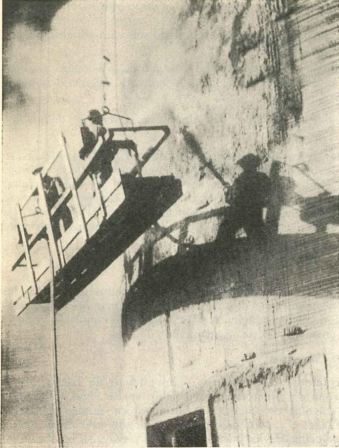
Silos para fertilizantes, en Bonanka (Polonia): Los silos se construyeron a base de segmentos prefabricados que se unían por medio de un pretensado circular. Los alambres de esta armadura de pretensado se recubrieron después con gunita.
