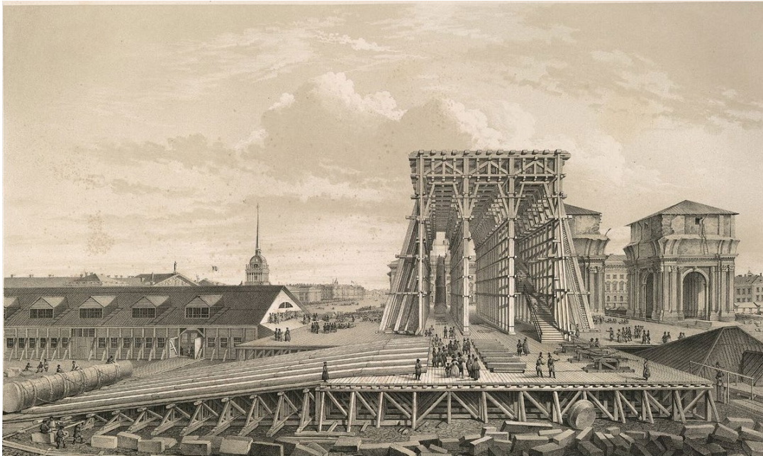
Figura 2. Vista de las operaciones de erección de la primera columna en un pórtico de la catedral de San Isaac en San Petersburgo. Colaboración del ingeniero Augustin de Betancourt con el arquitecto Auguste de Montferrand [1]
