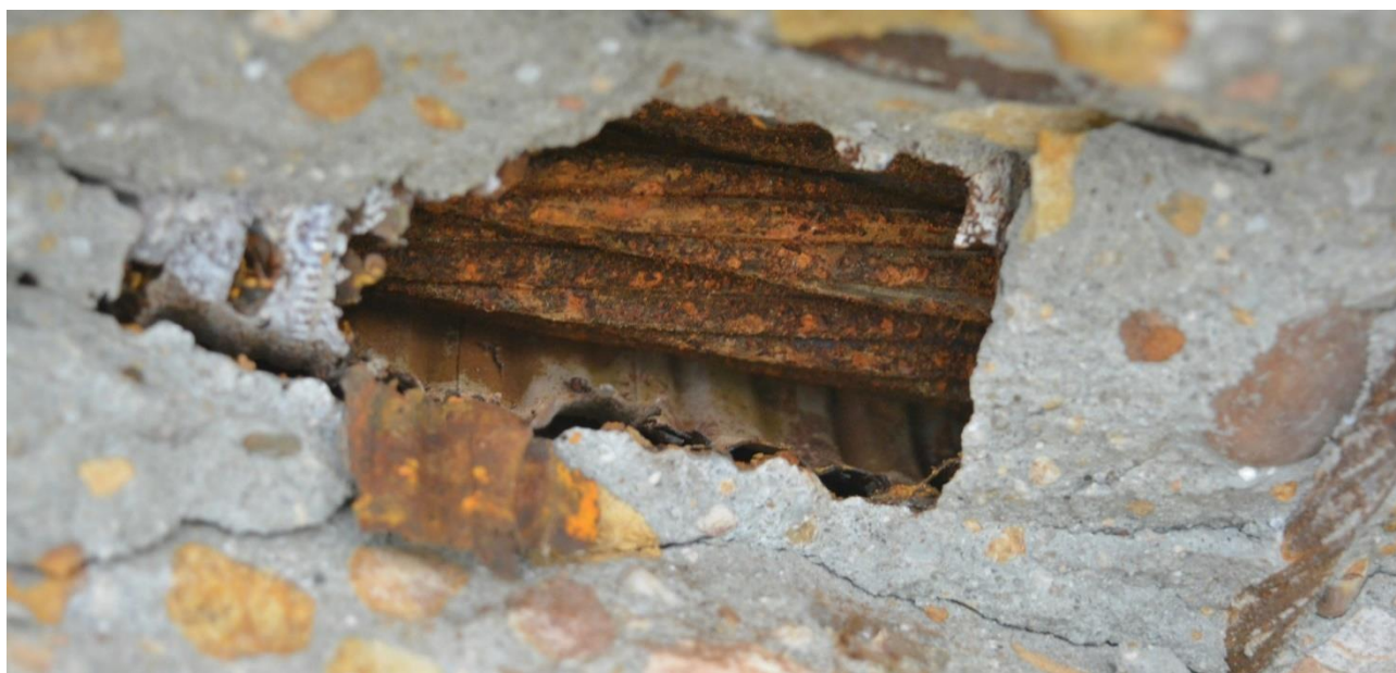
Figura 15. Tendón sin lechada en lado oeste del vano 6 (entre P-5 y P-6), en la calicata en la zona de la figura 13. Foto de los autores, 12.02.2020
