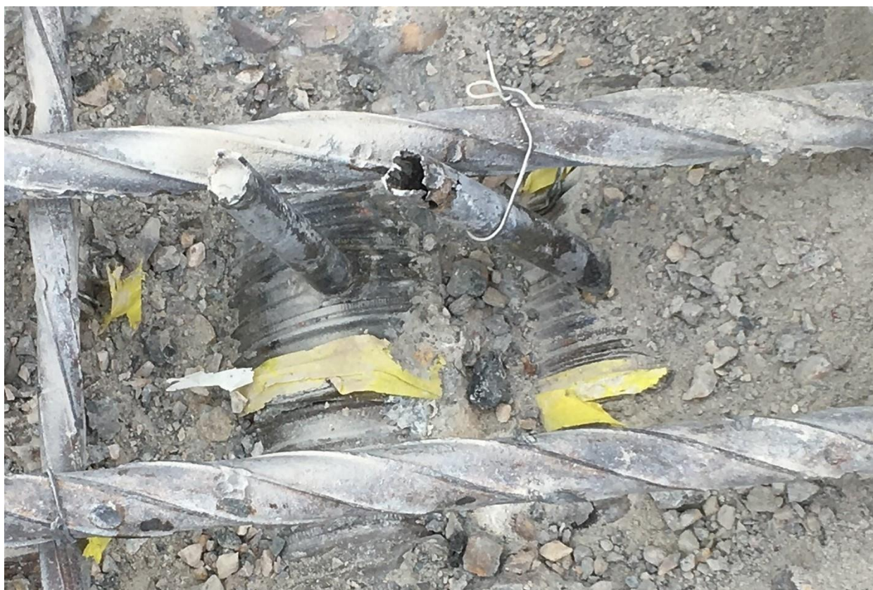
Figura 16. Vainas y tubos de purga sobre pila 6. Armadura pasiva estirada en frío, típica de la época (foto de los autores, 12.02.2020)
