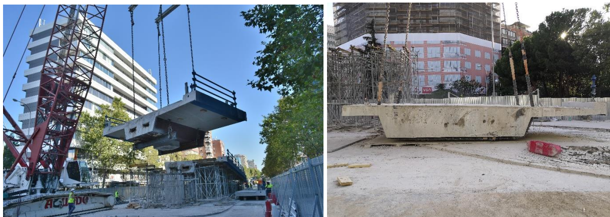
Figura 38. Sistemas de izado de piezas empleados: con balancines inferiores (izda.) y con eslinga de abrazo inferior (dcha.).
