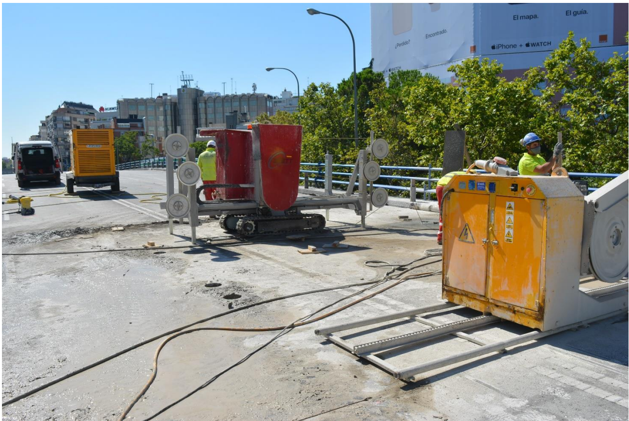
Figura 36. Equipos de corte con hilo de diamante
