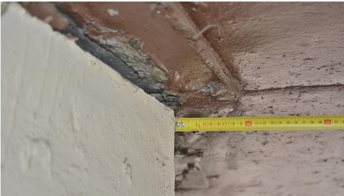
Figura 25. Corrimiento acumulado en la pila 9 (foto de los autores)
