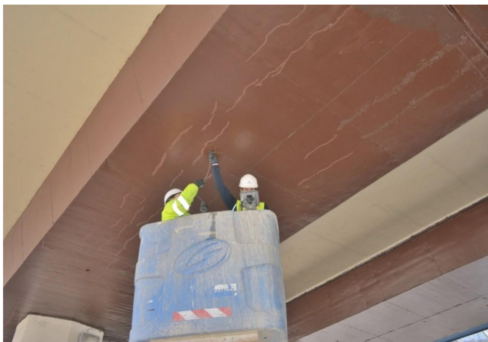
Figura 12. Fisuras longitudinales selladas en losa de fondo (foto de los autores, marzo de 2020)
