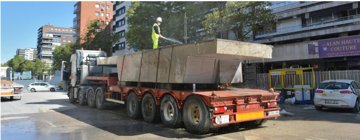
Figura 40. Transporte de pieza del tablero sobre plataforma
