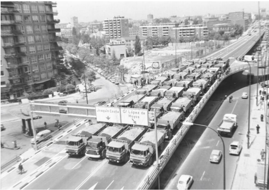
Figura 10. Prueba de carga del viaducto, 13 de mayo de 1970
