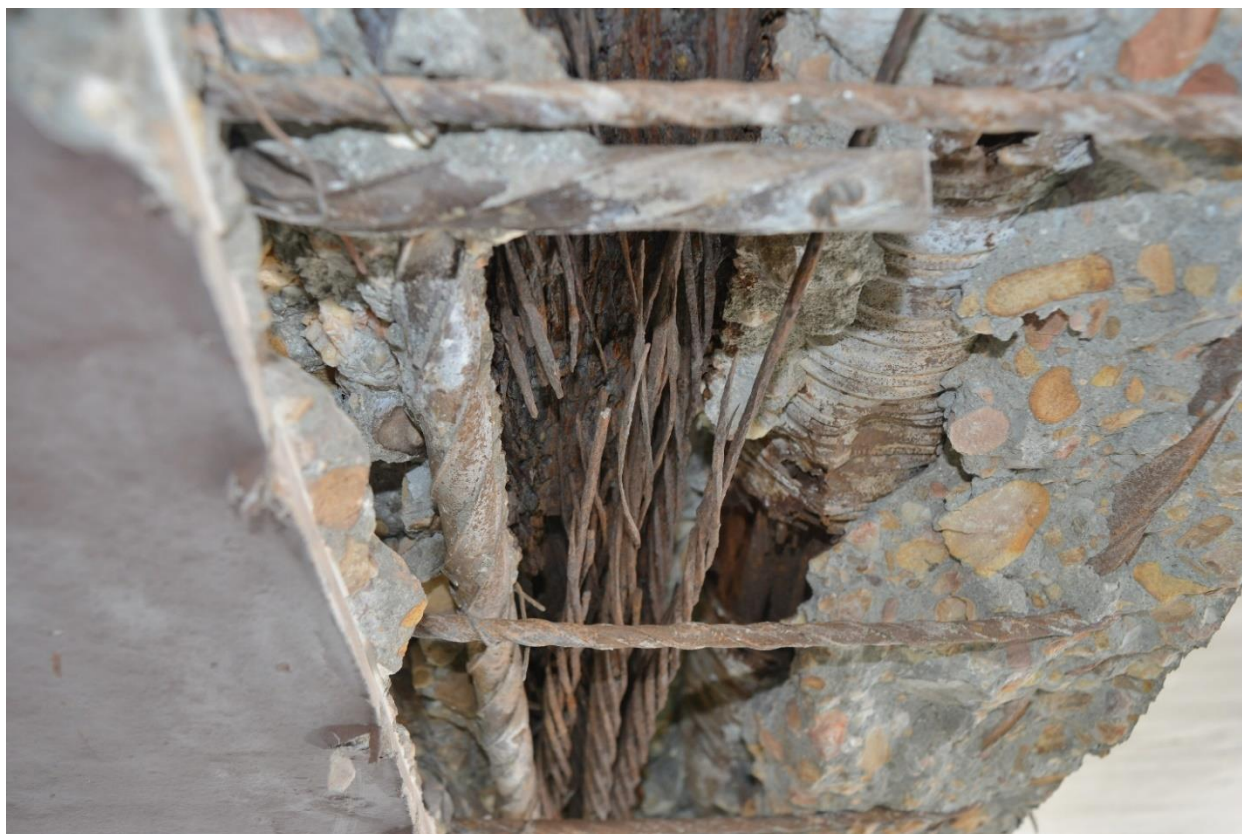
Figura 14. Tendón roto, sin lechada, detectado tras practicar una calicata en la zona de la figura 13. Foto de los autores
