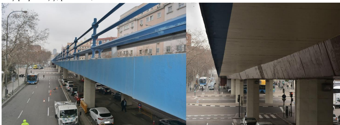
Figura 26. Correcta alineación de la estructura, sin flechas apreciables, o incluso aún con contraflecha. Fotos de los autores 12.02.2020
