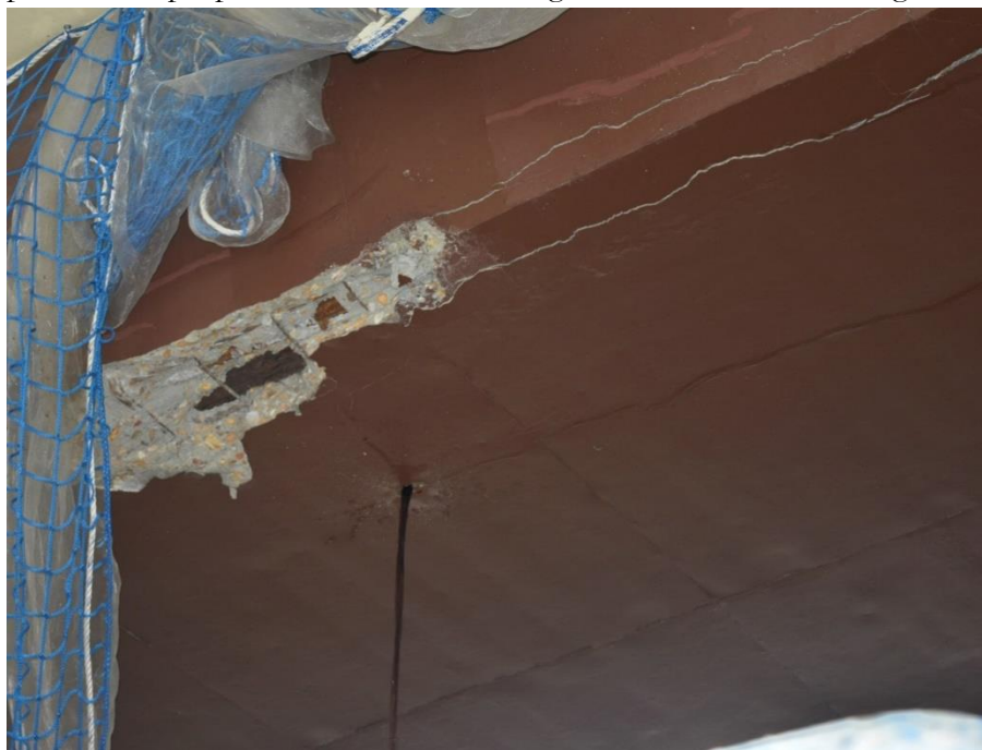
Figura 27. Drenaje del alvéolo contiguo al tendón roto en vano 6. Foto de los autores, 12.02.2020
