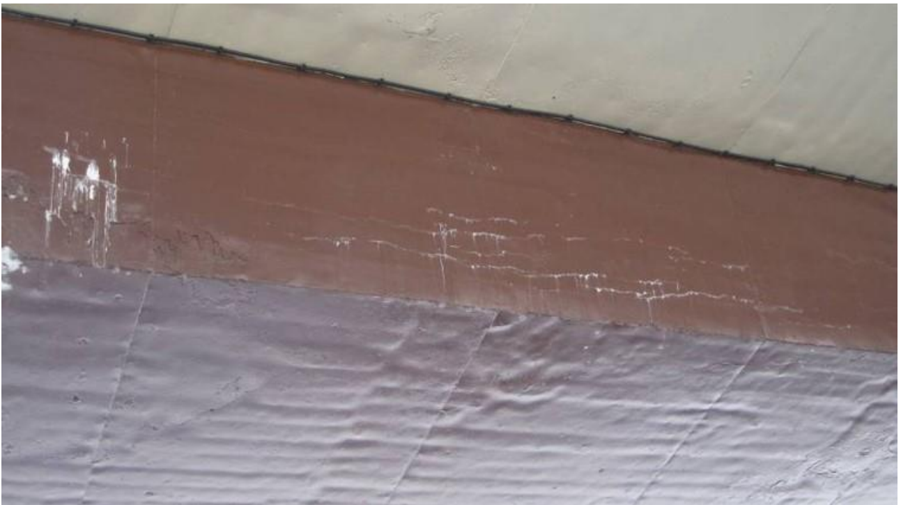
Figura 11. Fisuras longitudinales (foto del informe de inspección principal de INES Ingenieros Consultores, 2012, referido en [8])
