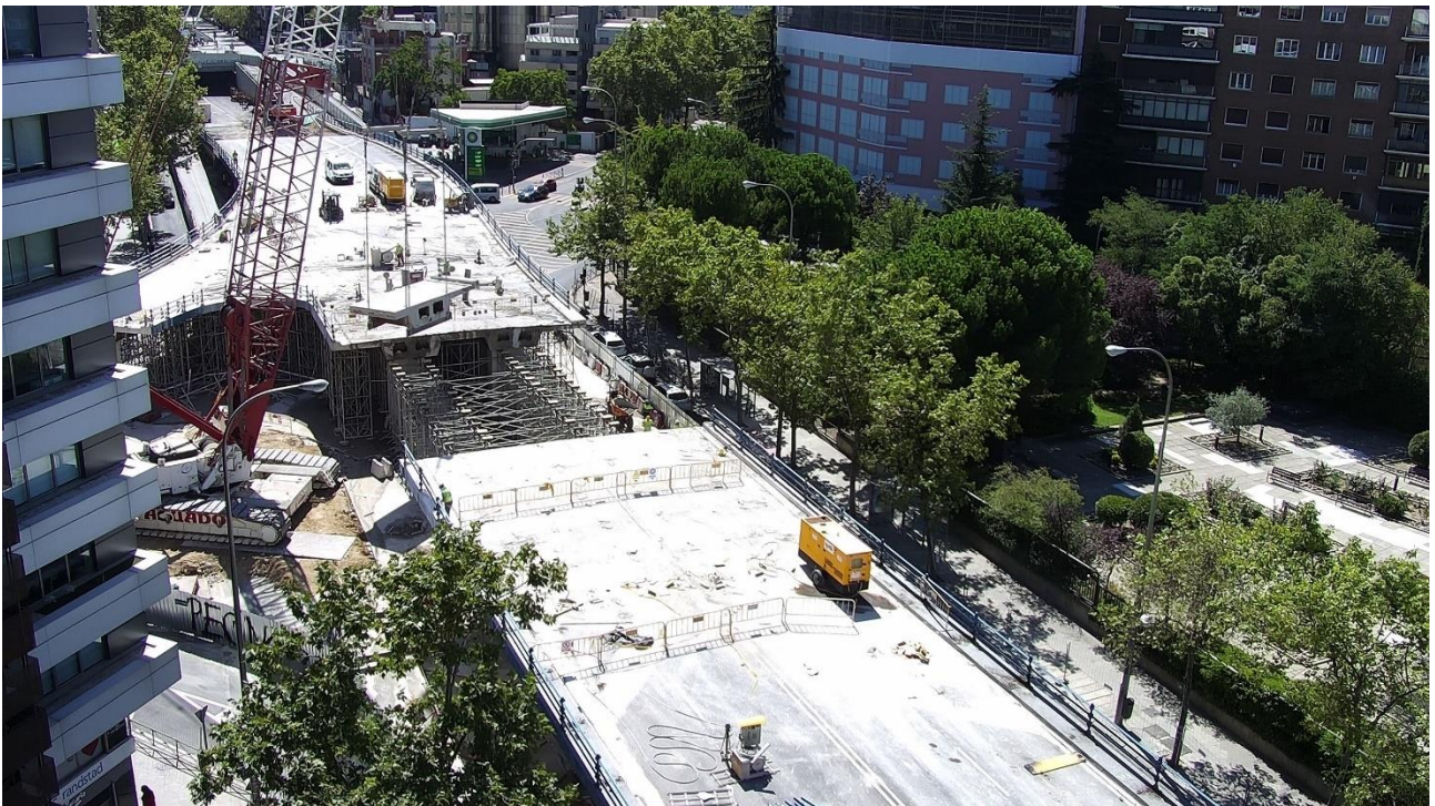
Figura 41. Desmontaje de vano 4
