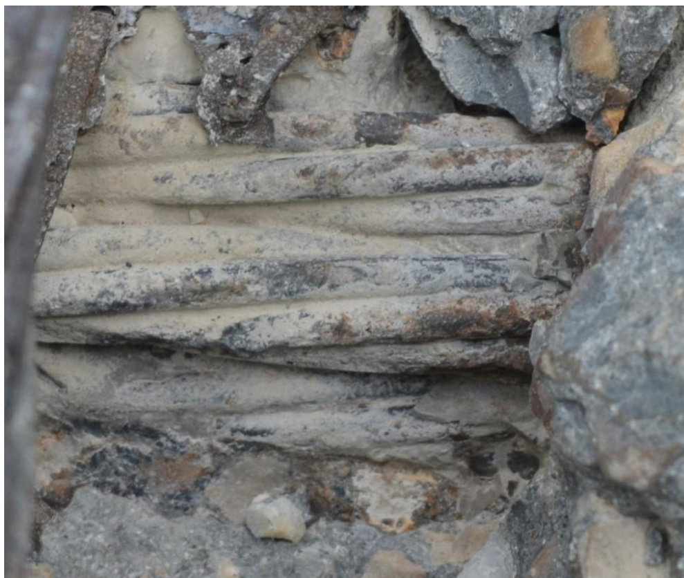
Figura 17. Calicata sobre pila 6. Foto de los autores, 12.02.2020
