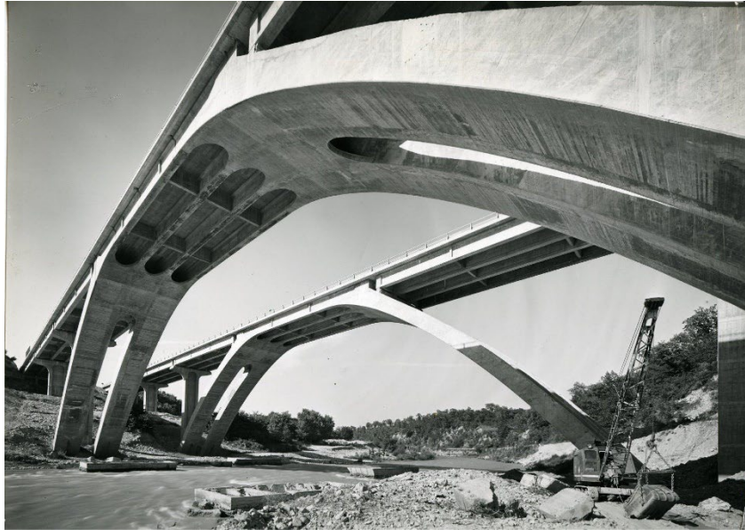
Figura 17 - Viaducto de Incisa (1962-1963) (Reproducida de [36])
