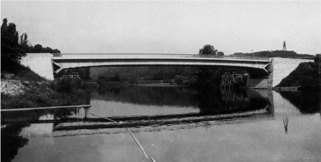
Figura 9. Puente de Luzancy sobre el Marne. Luz de 55 metros. 1945. (Reproducida de [7])
