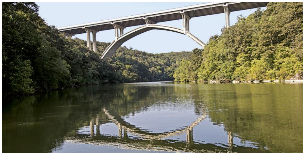
Figura 18 - Viaducto de Levane (1962-1963) (Reproducida de [34])
