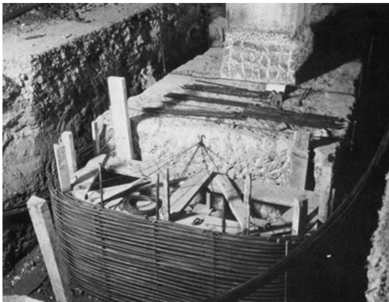
Figura 6. Bloques de anclaje en la Estación Marítima de Le Havre, solución de rehabilitación de Freyssinet (1934). (Reproducida de [7])
