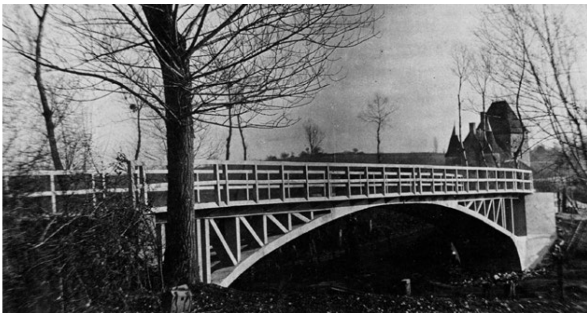
Figura 2. el puente de tres articulaciones de Praireal-sur-Besbre (1907). (Reproducida de [7])
