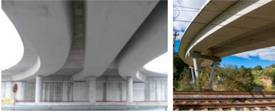
Figura 12. Imágenes de puentes curvos con soluciones prefabricadas.
