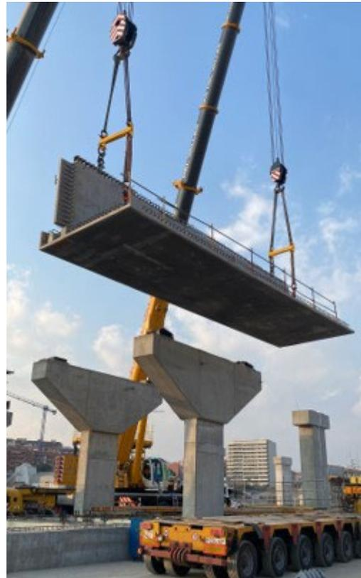
Figura 17. Imágenes de la colocación de semivigas para la construcción del entramado principal de cajones.
