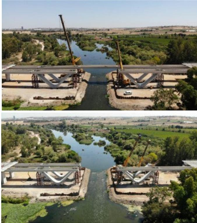
Figura 14. Imágenes de puentes de pilas en V prefabricadas y con jabalcones.
