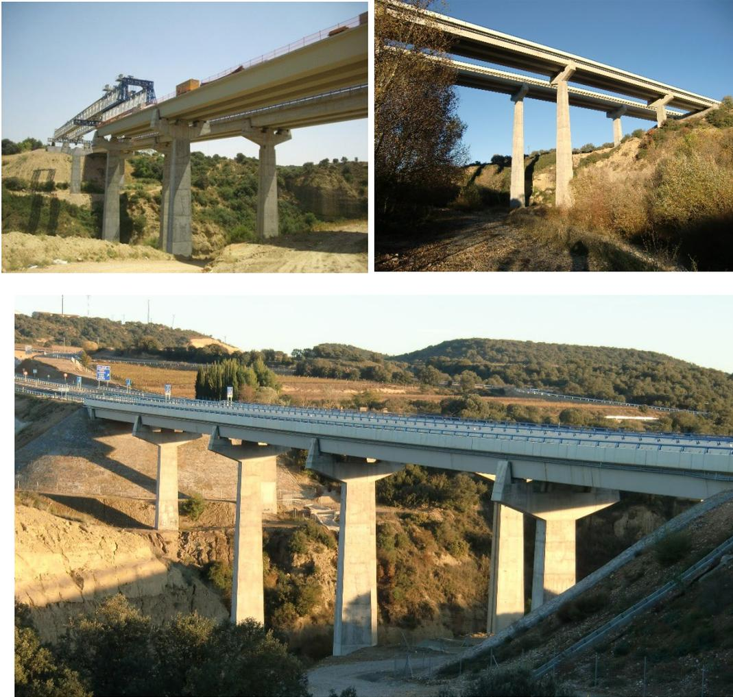
Figura 6. Imágenes de la duplicación del puente sobre el río Alcanadre (Huesca): vista inferior durante el montaje con lanzavigas, vista inferior y vista general acabado.
