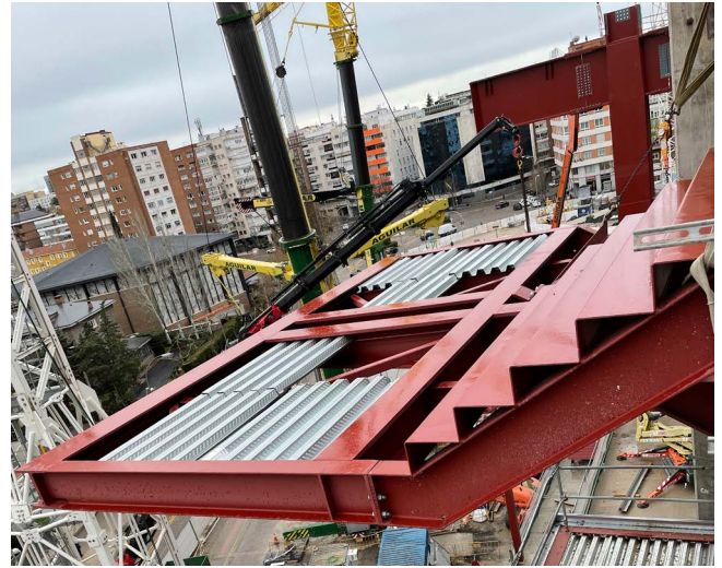
Figura 28. Escalera volada. Detalle de meseta exterior.
