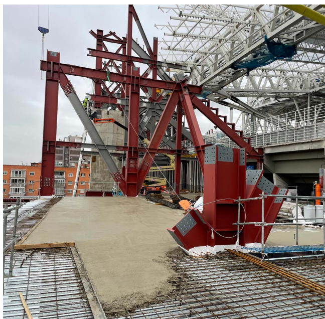
Figura 11. Pórtico tipo principal en ejecución.
