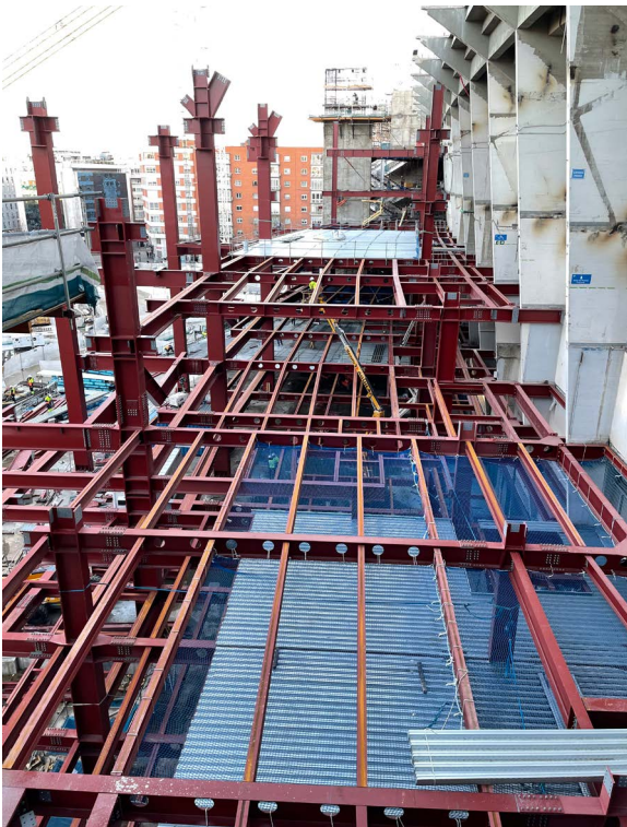
Figura 3. Ejecución de forjado de chapa colaborante.
