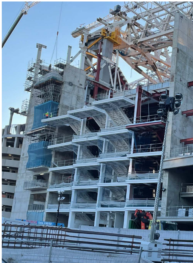
Figura 27. Escalera volada en ejecución.
