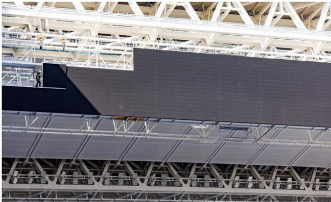
Figura 69. Instalación de las pantallas del videomarcador.
