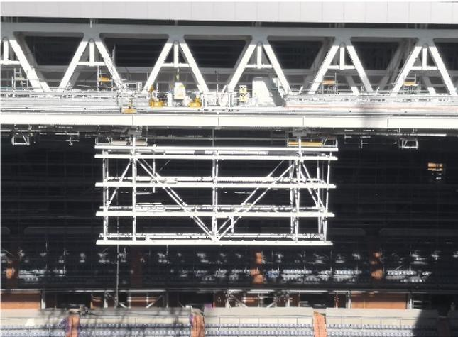
Figura 65. Izado del módulo central. Módulo 3.
