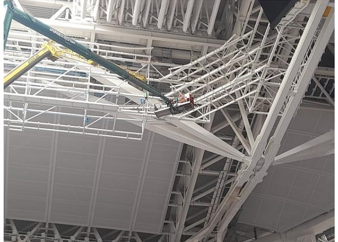
Figura 72. Colocación de las vigas de apoyo de la pasarela.
