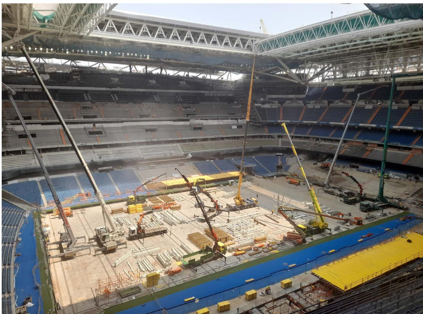
Figura 45. Izado del resto de la estructura.
