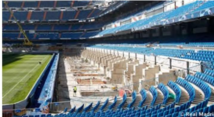
Imagen 19. Columna de hormigón para apoyo de vigas metálicas en voladizo
