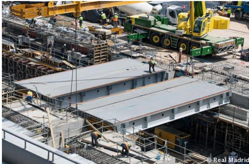
Imagen 11. Montaje de módulos de tapa
