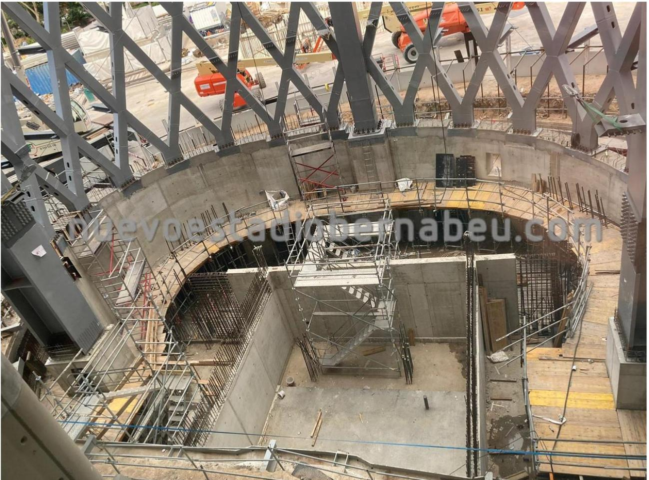
Figura 12. Vista de la nueva cesta metálica de la torre y del arranque de los elementos de hormigón en el sótano.
