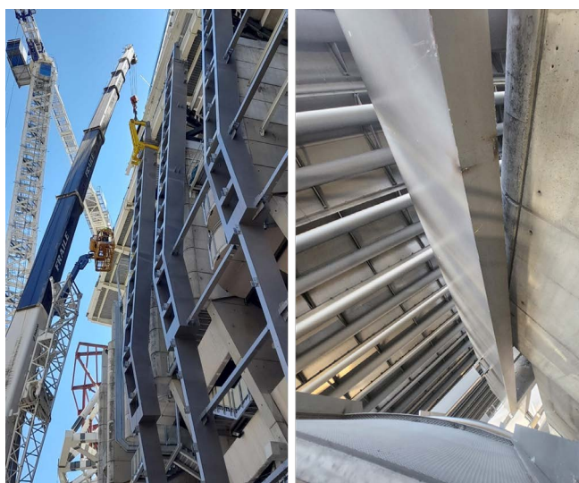
Figura 9. Izquierda: Izado de costillas “diapasón”. Derecha: Costilla diapasón abrazando costilla de hormigón existente.
