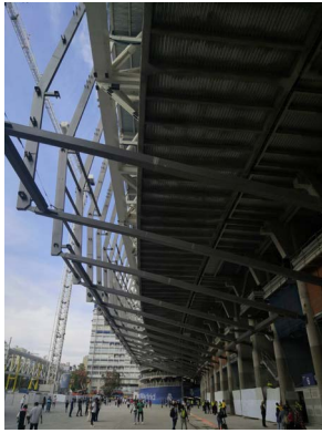
Figura 17. Izquierda: Puntos de sofito oeste. Montaje parcial, previamente a la colocación de arriostramientos en su plano. Derecha: Arriostramientos y juntas de movimiento en sofito oeste.
