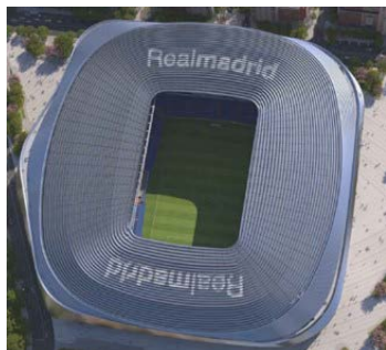
Figura 4. Vista general cubierta retráctil recogida.
