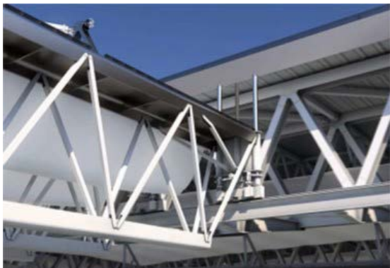
Figura 7. Vista general sistema de traslación.
