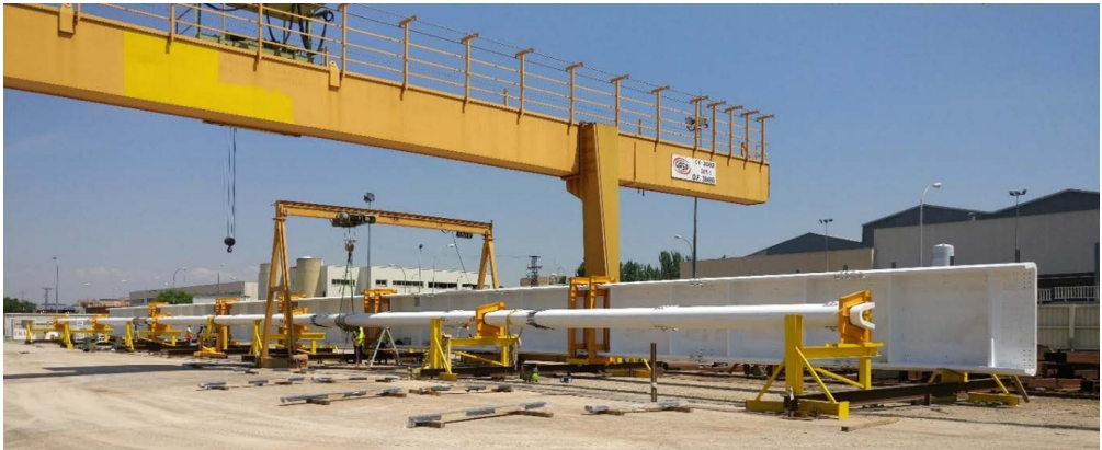
Figura 39. Proceso de curvado cercha en taller.
