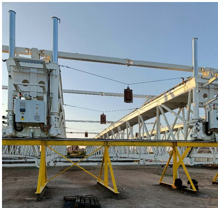
Figura 63. Prueba de carga.
