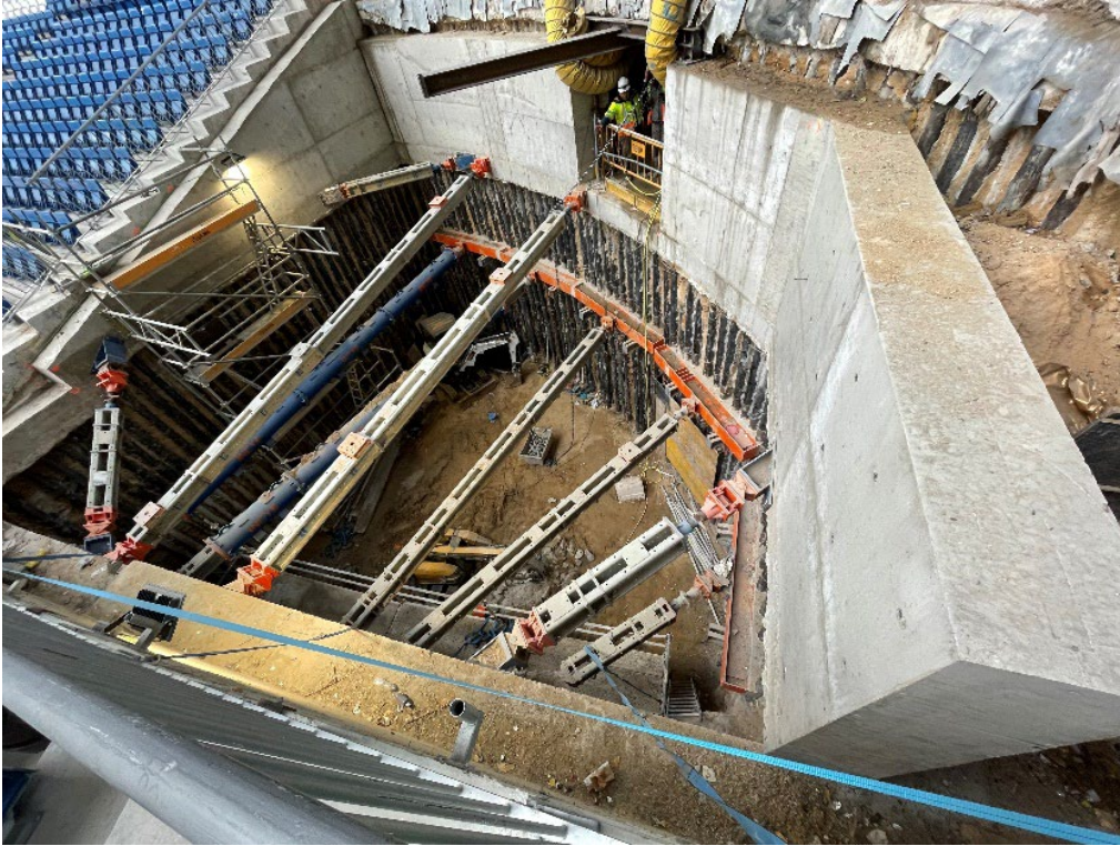
Figura 34. Imagen proceso constructivo de las salas de contacto con arriostros temporales. Fotografía tomada por el equipo de diseño en visita a obra
