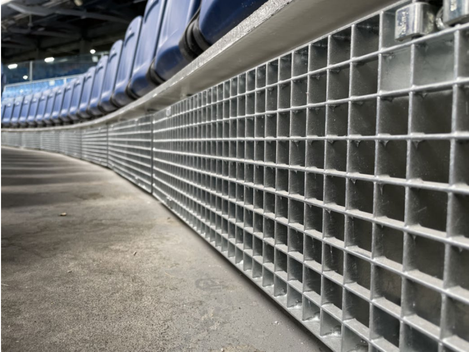
Figura 36. Imagen de tabicas de rejilla metálica en zona de grada baja para toma de aire. Imagen tomada por equipo de diseño en visita a obra.
