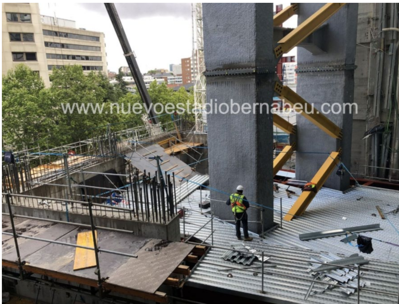
Figura 4. Imagen de obra de ejecución de la estructura del péndulo de torreón norte. Imagen procedente página web del club,
