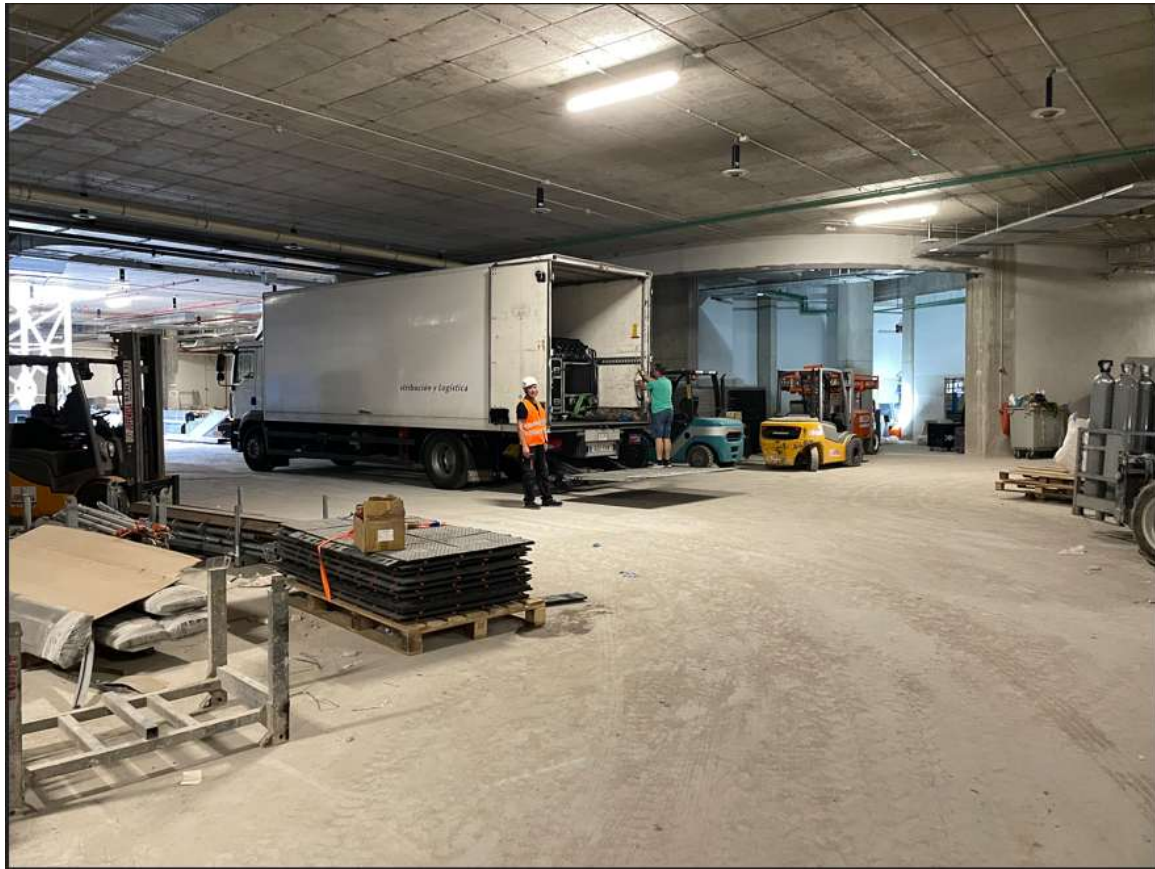
Figura 4. Paso de camiones en sótano 2
