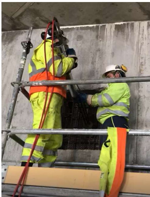
Figura 23 Destesado y retirada de anclajes con muro forro.
