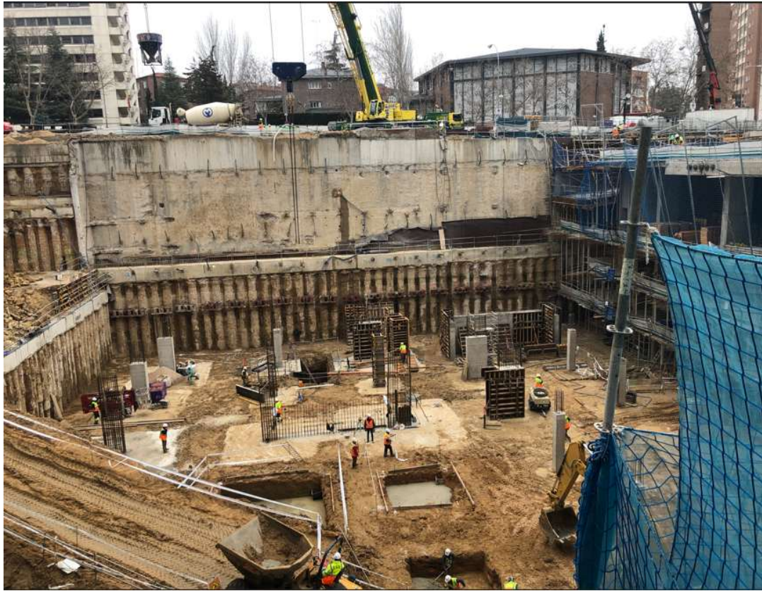
Figura 30 Ejecución de zapatas en extremo norte del sótano 5
