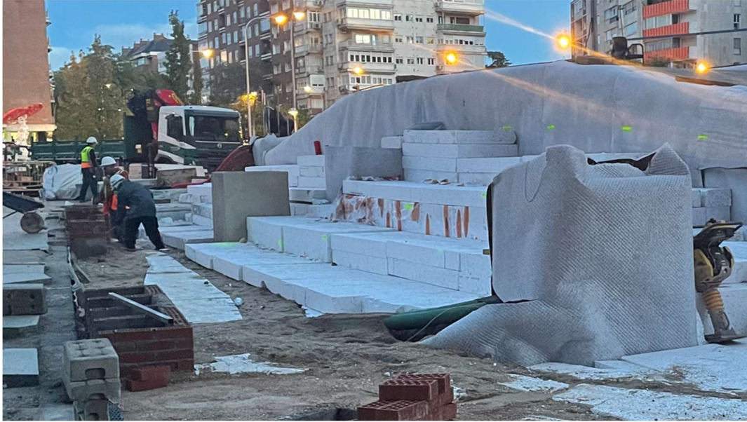
Figura 6. Poliestireno expandido para formación de volúmenes en parterres de Plaza Pública.
