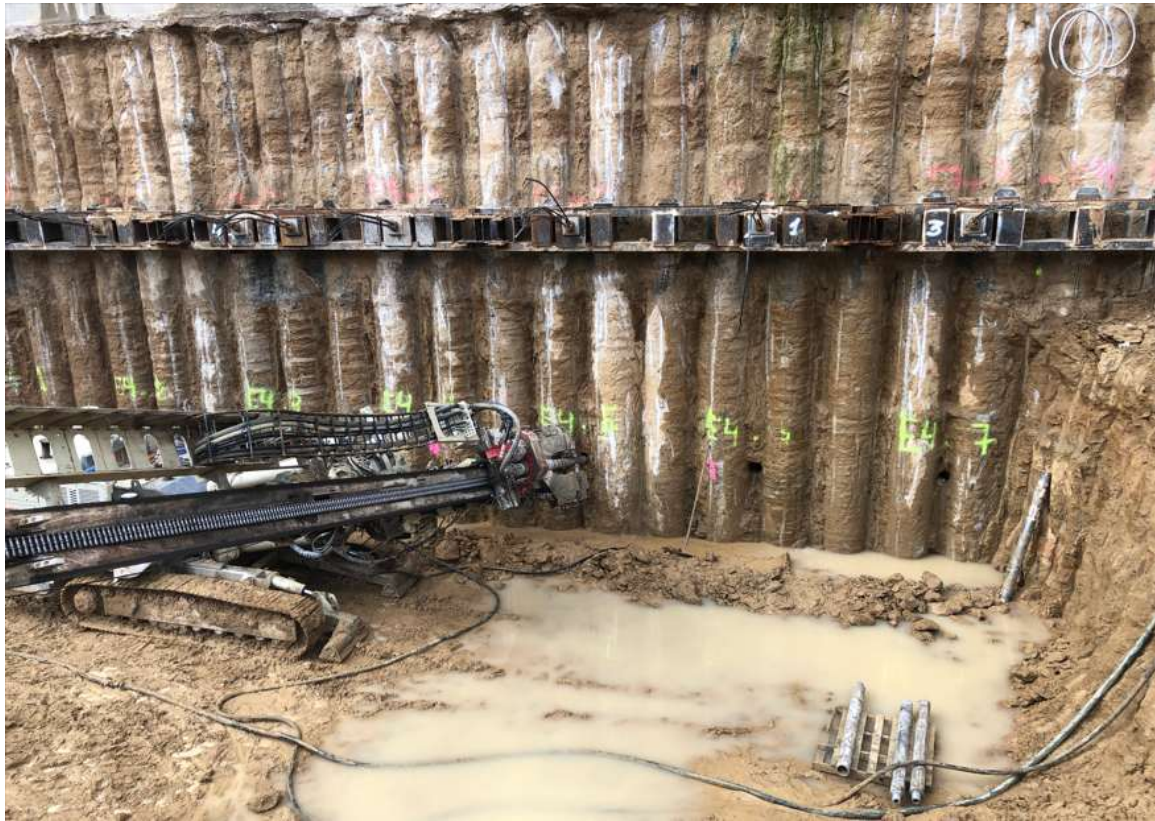
Figura 22 Ejecución de anclajes al terreno.
