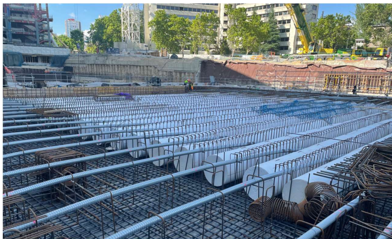
Figura 9 Ejecución de losa aligerada
