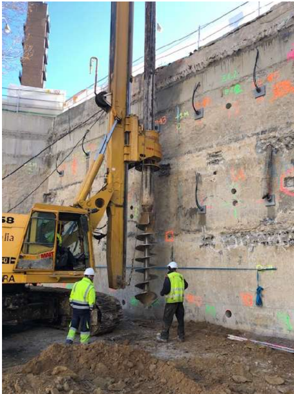
Figura 20 Ejecución de pilotes en intradós de pantalla existente
