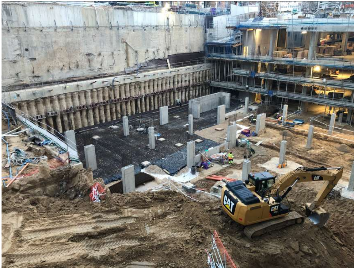
Figura 3. Sótanos del 5 al 1 ejecutados en lado sur y ejecución del resto de zapatas y pilares del sótano 5 en lado norte.
