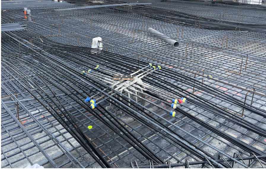
Figura 10 Detalle de pretensado en forjado de Planta Primera.
