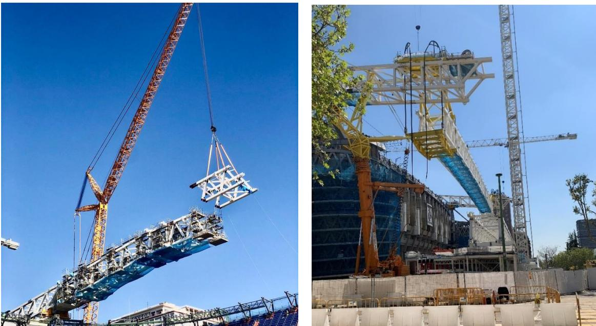
IMAGEN 40 - IZADOS CON GRÚA DE GRAN TONELAJE Y HEAVY LIFTING
