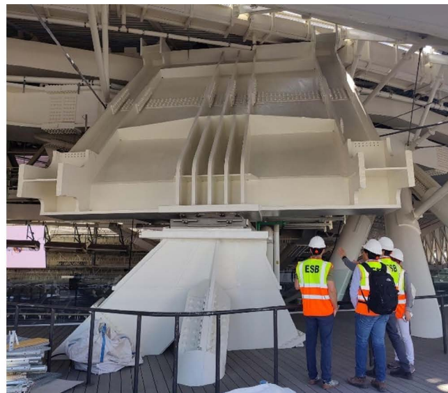
Figura 4. Apoyo esférico.
