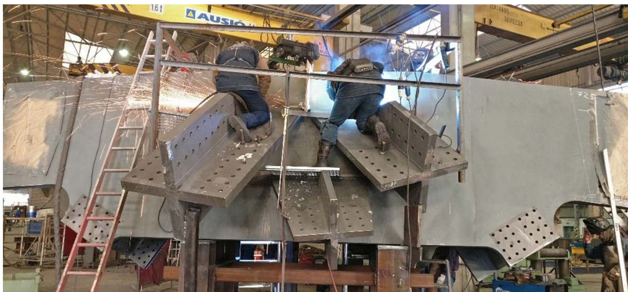
Figura 12. Ejecución de nudo corona en taller.
