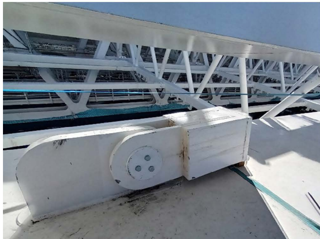
Figura 13. Bielas de bloqueo Norte/sur entre Corona y Cubierta.
