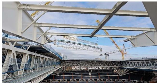
Figura 48. Montaje cerchas cubierta retráctil.
