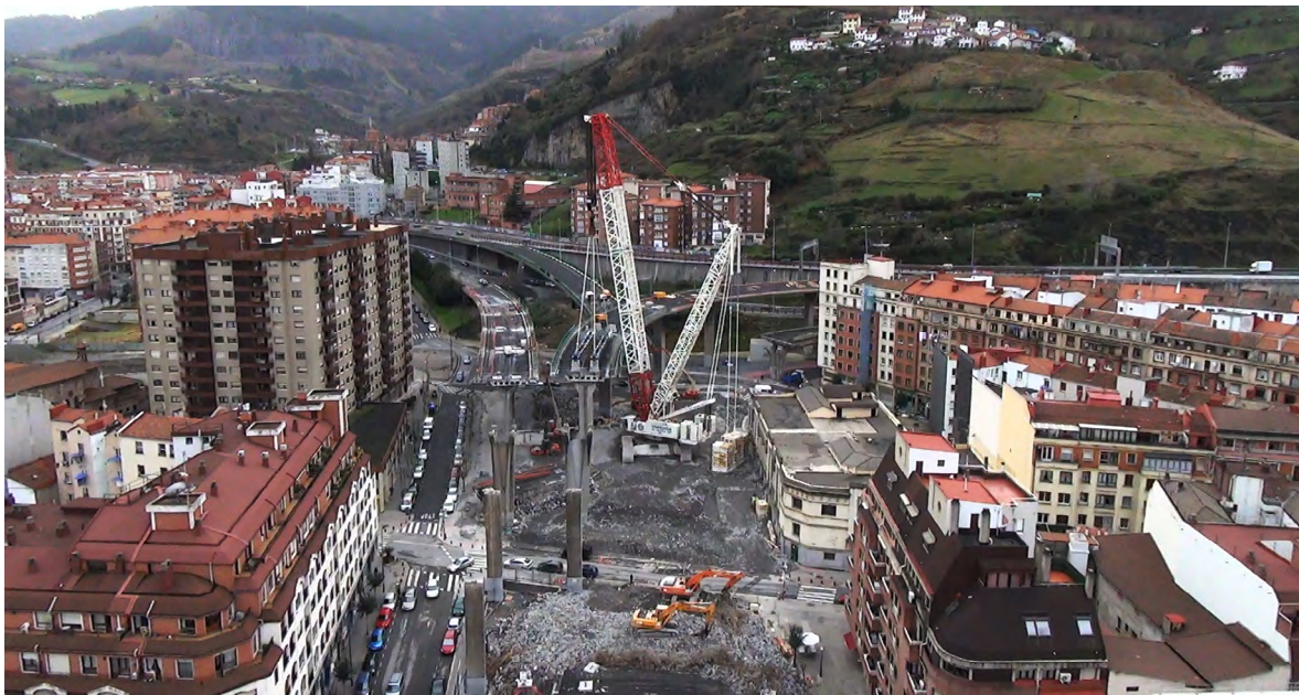
Figura 32. Vista general de la calle Sabino Arana durante la fase de demolición de los viaductos.
