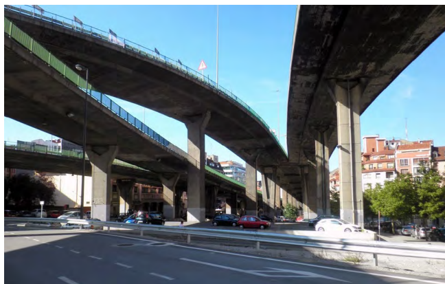
Figura 4. Vista de los 4 ramales principales del enlace de la calle Sabino Arana.
