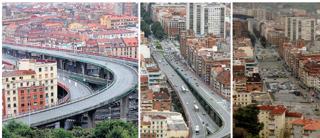
Figura 3. Vista de los ramales de acceso del viaducto antes de la demolición (izda.) Vista del tronco principal del enlace antes de la demolición (centro). Vista de la calle Sabino Arana tras la demolición de los viaductos (dcha.).
