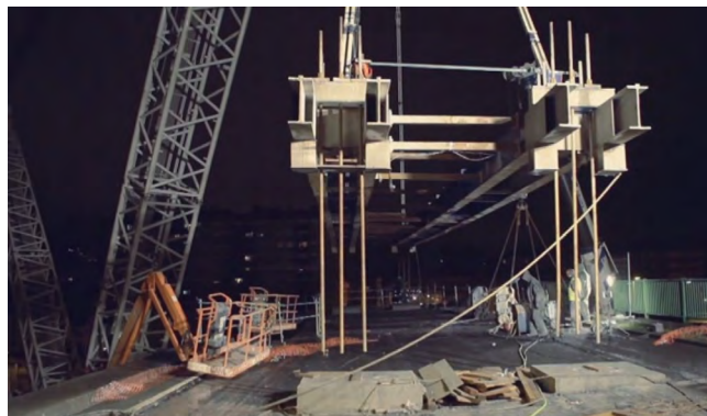
Figura 19. Operación de enhebrado de barras Dywidag en el tablero
