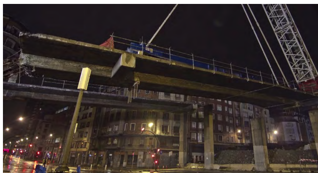
Figura 14. Ejemplo de demolición con grúa en horario nocturno para evitar afcción a línea de Tranvía.
