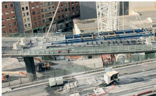
Figura 17. Vista general de bastidor metálico y peanas para absorber el cambio de pendiente.
