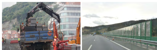
Figura 9. Retirada de pantallas acústicas (Izda.) y aprovechamiento en otras zonas de la autovía A-8 (Dcha.).
