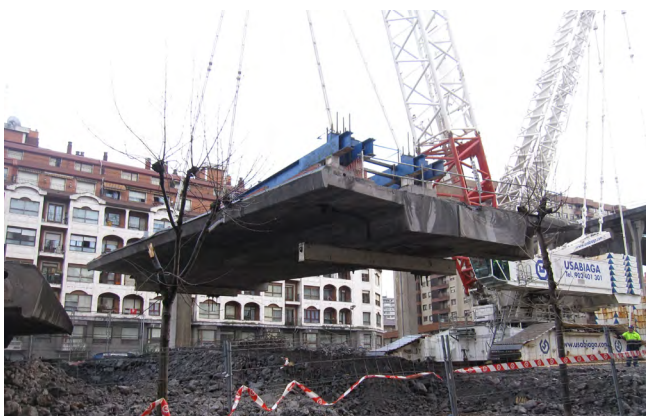
Figura 22. Posado de tramo de tablero en el suelo, previo a acometer su demolición mecánica.
