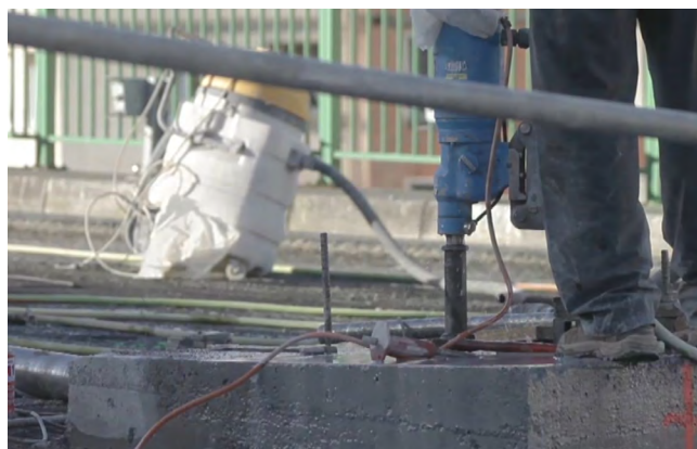
Figura 18. Perforación de orificios en el tablero para enfilarse las barras Dywidag.
