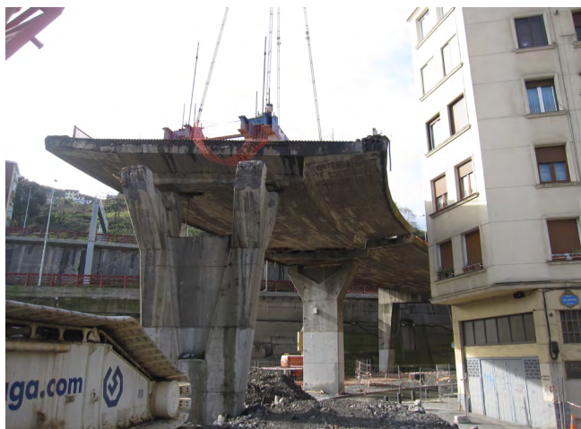
Figura 13. Ejemplo de demolición con grúa en la cercanía de viviendas.
