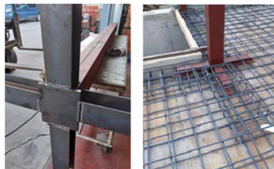
Figura 4. Conectores del tipo cruceta, soldados a columna formada por 2 UPNs en cajón cerrado. Capitel empleado en la resolución de una losa maciza en edificación.
