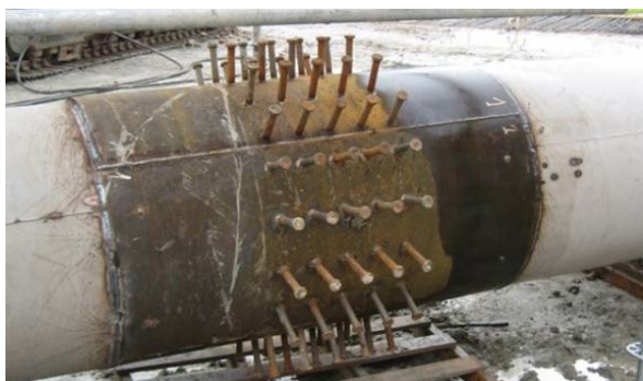
Figura 1. Conectores soldados a una columna metálica tubular. Solución de pila-pilote empleada en obras para de Metro de Madrid.
