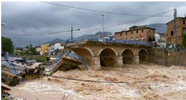
Figura 6. Hundimiento del puente de Beniarbeig (Alicante), el 11 de octubre de 2007.
