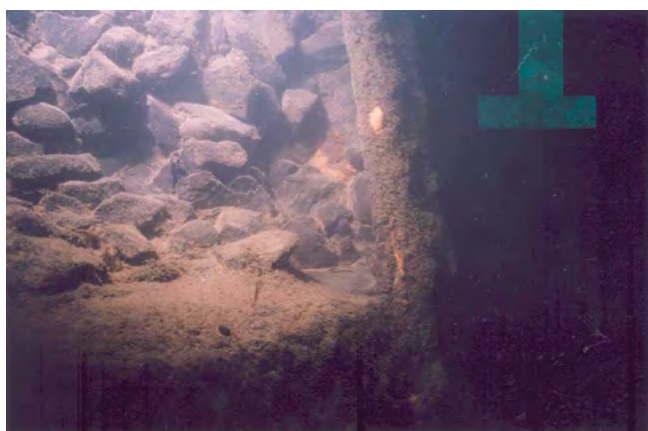
Figura 35. Hormigón lixiviado (ligante disuelto) y degradado en el puente de San Clodio, sobre el Sil. Trabajo de los autores en 2004.
