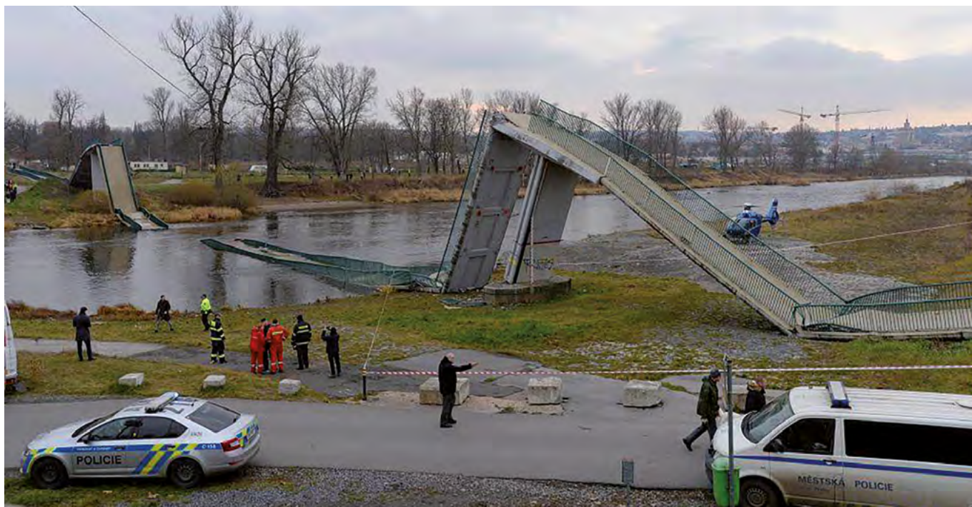
Figura 32. Banda tesa de una pasarela. Troja, cerca de Praga, República Checa, 2 de diciembre de 2017.
