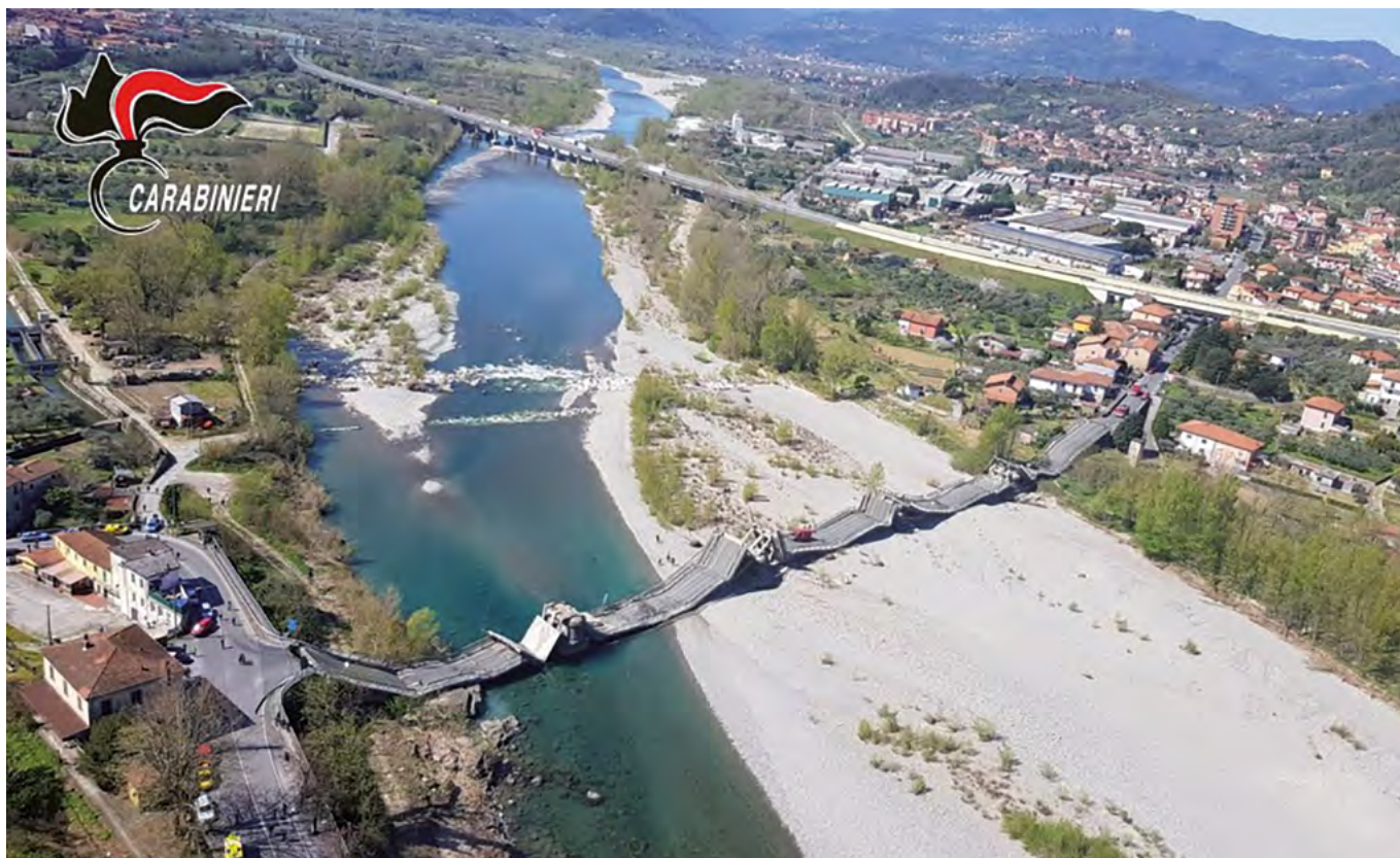
Figura 34. Colapso del puente de Albano Magra, 8 de abril de 2020. Foto difundida a los medios de comunicación.
