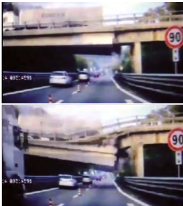
Figura 21. Ejemplo de colapso de un apoyo intermedio a media madera, en dos fotogramas (tomado de [19]).
