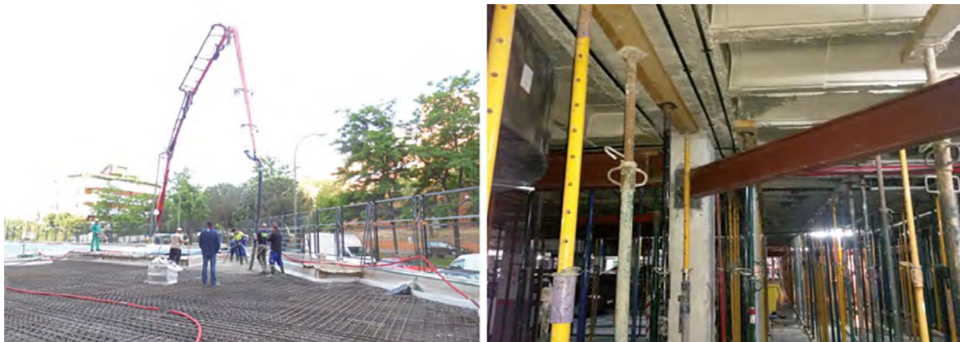
Figura 6. Nueva losa de hormigón armado por cara superior, y vista de los perfiles metálicos de refuerzo por cara inferior.
