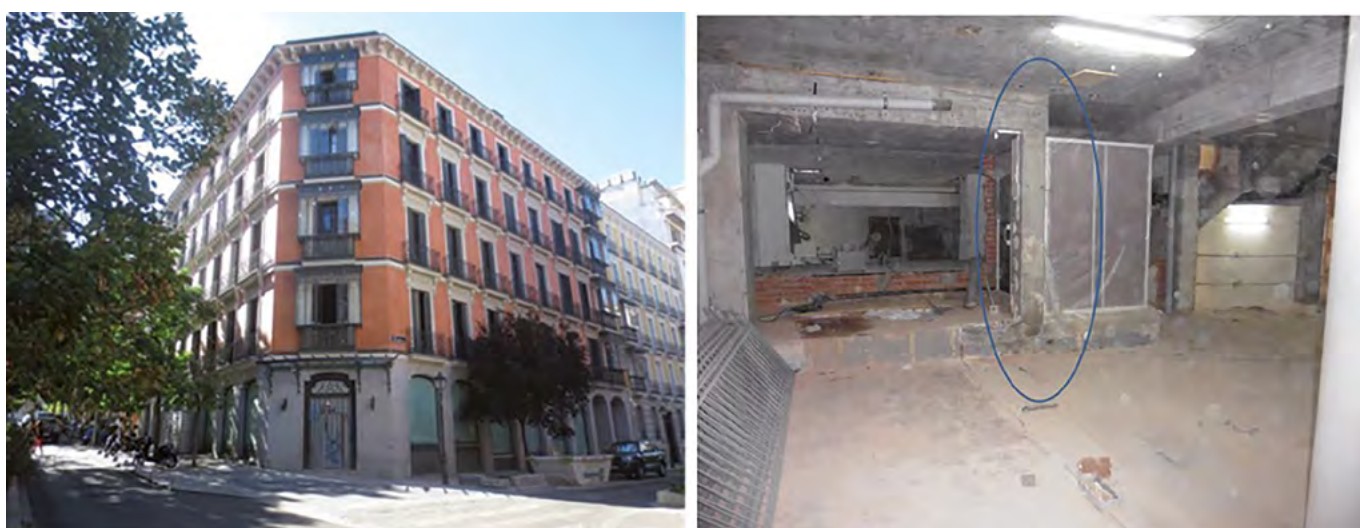
Figura 13. Vista del edificio y del tramo de pilar a suprimir.
