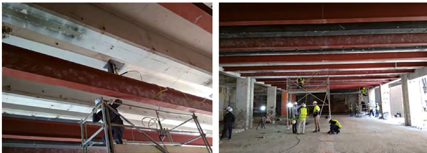
Figura 8. Refuerzo de una losa nervada de hormigón armado.
