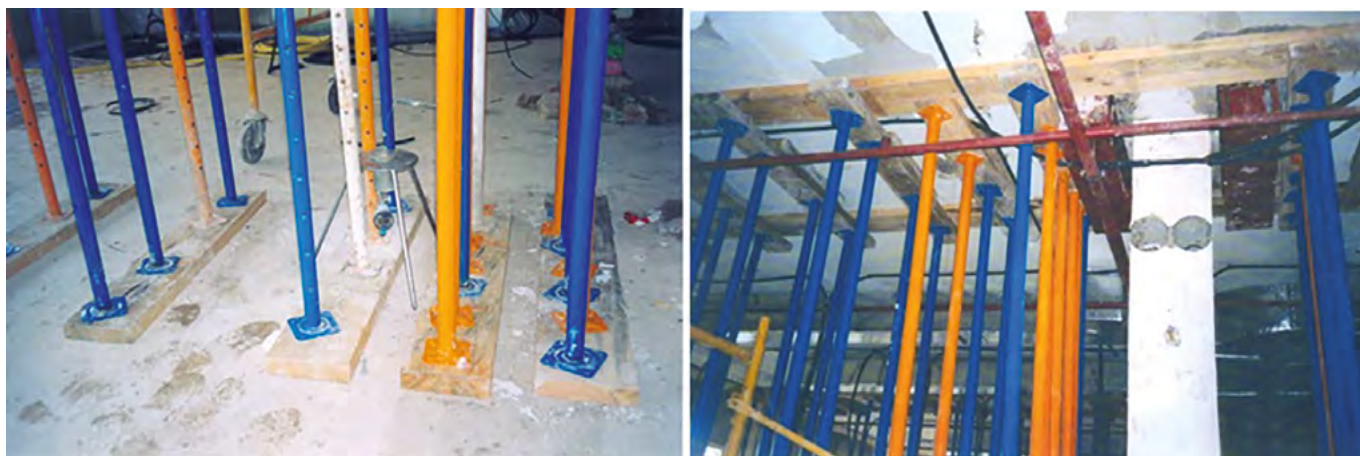
Figura 12. Comparador de precisión 0,01 mm dispuesto para medida de las flechas (fotografía de la izquierda) que iba tomando el perfil de refuerzo al apretar las tuercas para acortar la longitud del tirante. Corte del pilar con sonda (fotografía de la derecha).
