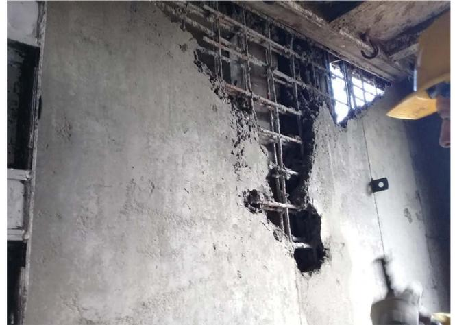
Figura 2. Problemas en el vaciado del concreto.
