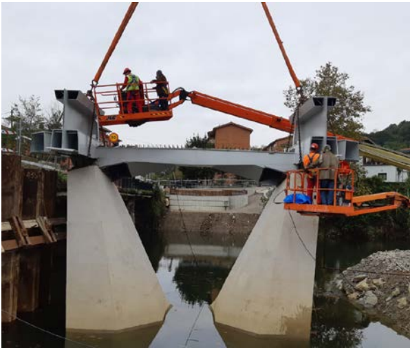
Figura 11. Colocación de nudo en pila
