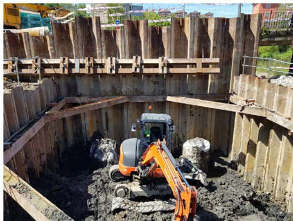
Figura 6. Pantalla y recinto de tablestacas en margen izquierda
