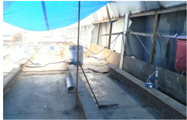
Figura 17. Acelerómetros en fase de construcción
