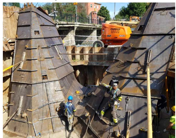
Figura 10. Encofrado de pila
