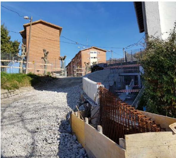
Figura 8. Muro en rampa del caserío
