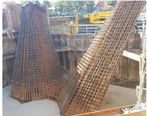
Figura 9. Ferralla alrededor del bastidor metálico de pila
