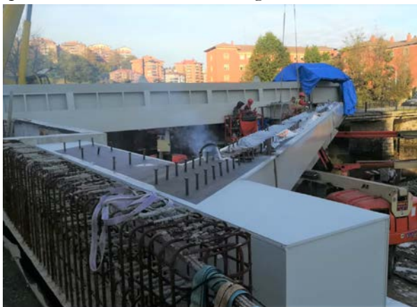
Figura 15. Colocación de pasarela aguas arriba
