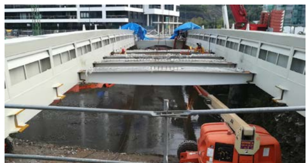
Figura 14. Soldadura de costillas transversales
