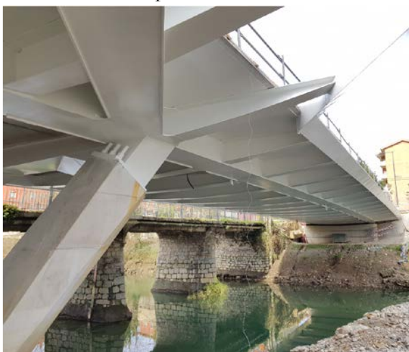
Figura 16. Estado actual de la obra del Nuevo Puente de Espartxo
