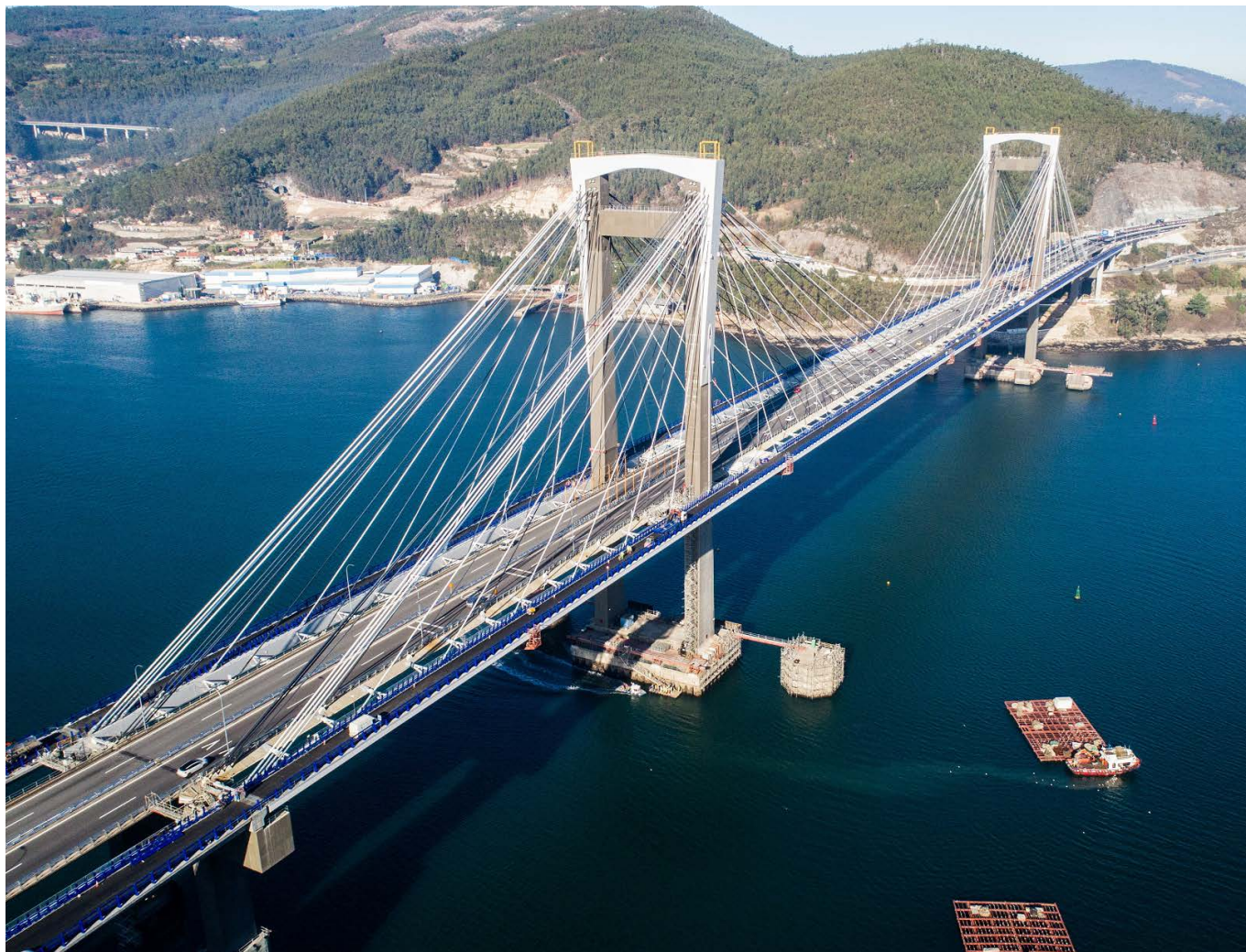
Figura 17. Vista del puente finalizado.
