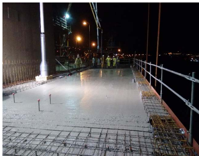
Figura 16. Trabajos nocturnos de hormigonado de la losa.
