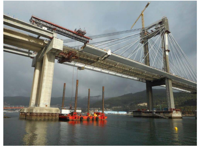
Figura 11. Viga de elevación de dovelas de extremo en el lado sur.
