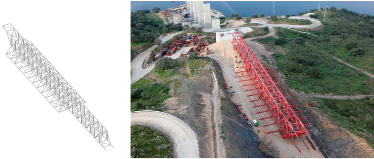
Figura 7. Viga principal de la Autocimbras empleadas en los vanos de acceso (Modelo 3D e imagen aérea).
