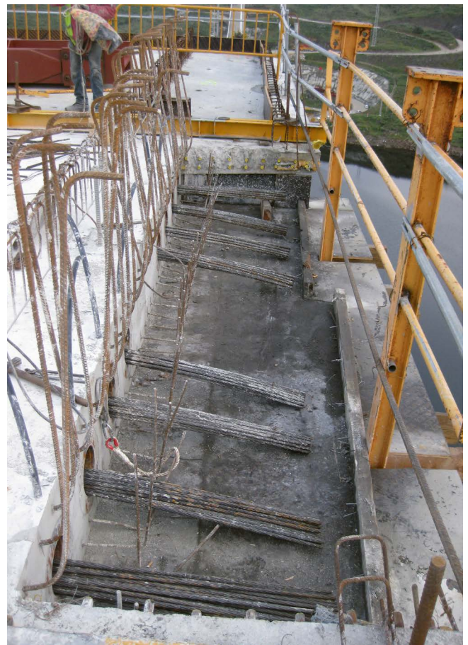
Figura 29. Pretensado transversal de la riostra de la pila P6.
