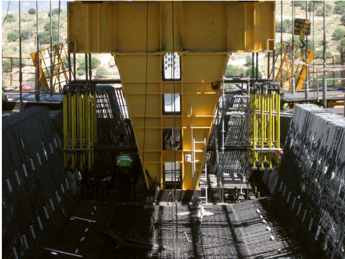
Figura 28. Barras Macalloy embebidas en la riostra de la pila P15 para el anclaje de la torre.
