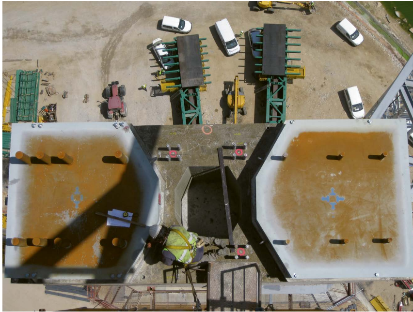
Figura 27. Apoyos POT provisionales de pila P15.
