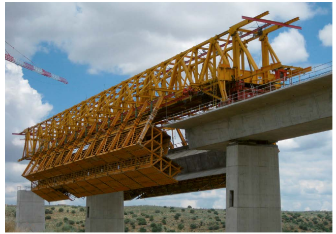
Figura 14. Imagen autocimbra con el encofrado exterior abierto.
