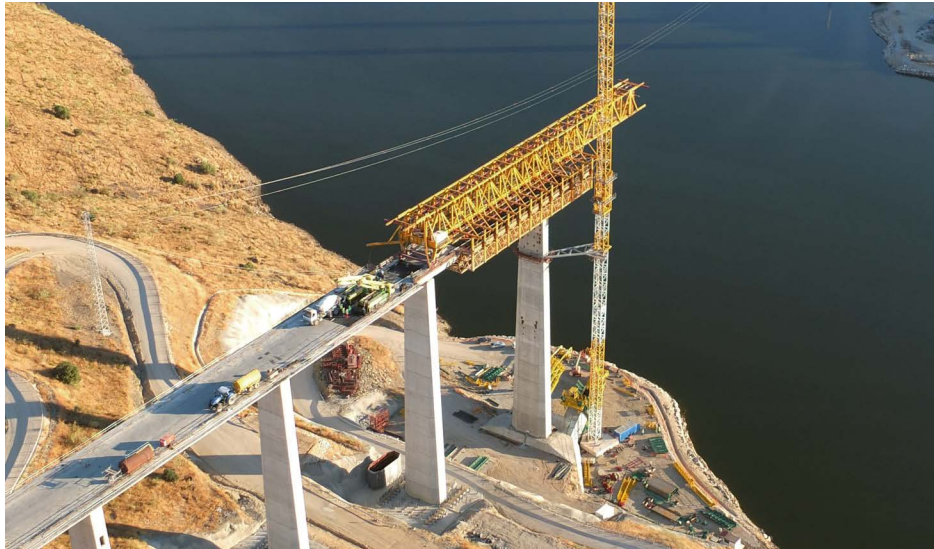
Figura 9. Pórtico de apoyo trasero empleado en la ejecución de los vanos de acceso del Margen Sur.
