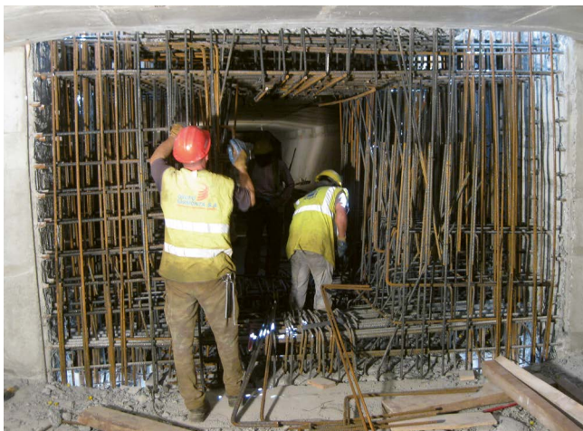
Figura 19. Ejecución en segunda fase de una riostra de pila tipo.
