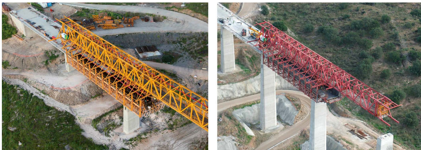
Figura 1. Imágenes aéreas de la ejecución de los vanos de los margen sur y norte con autocimbra superior.
