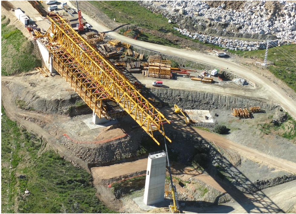
Figura 21. Imagen aérea del montaje del encofrado Exterior en la Autocimbra Sur.
