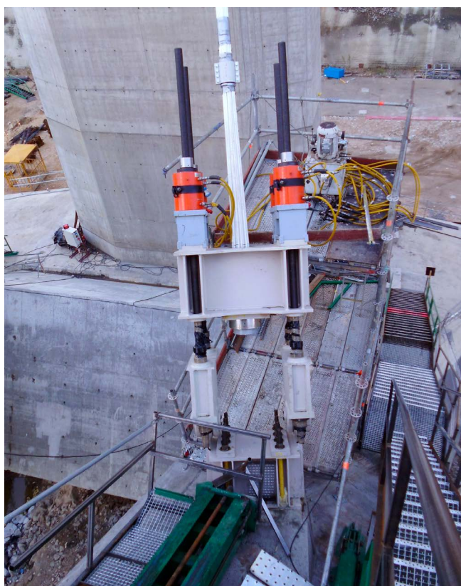
Figura 37. Proceso de tesado de un tirante en el arco.
