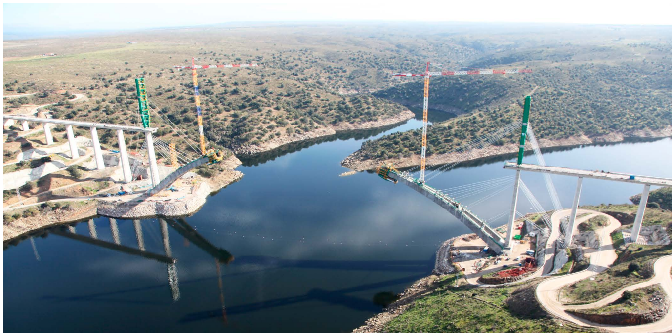
Figura 4. Vista general de la construcción del arco.
