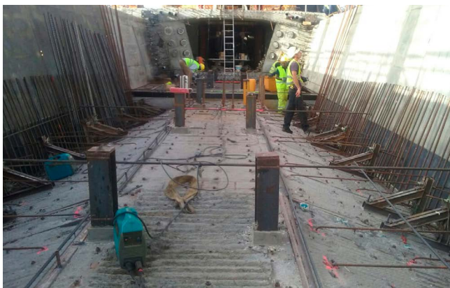
Figura 25. Vista general de la construcción del tablero en zona de conexión.
