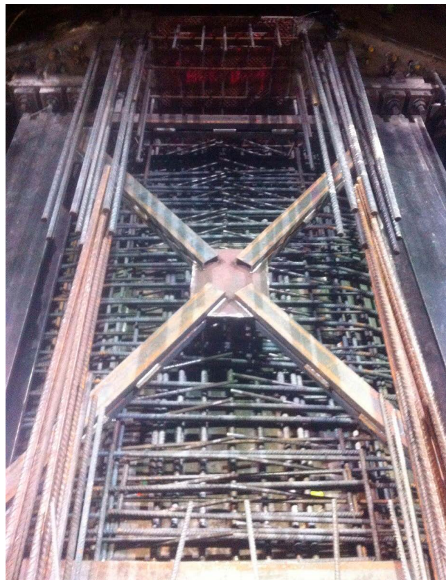
Figura 44. Montaje de ferralla con el bloqueo en clave realizado.
