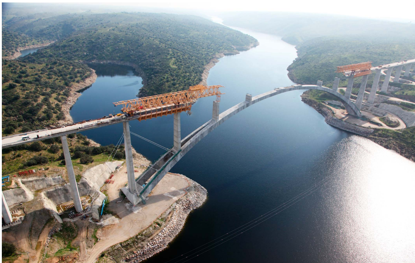
Figura 1. Vista general del puente durante construcción.
