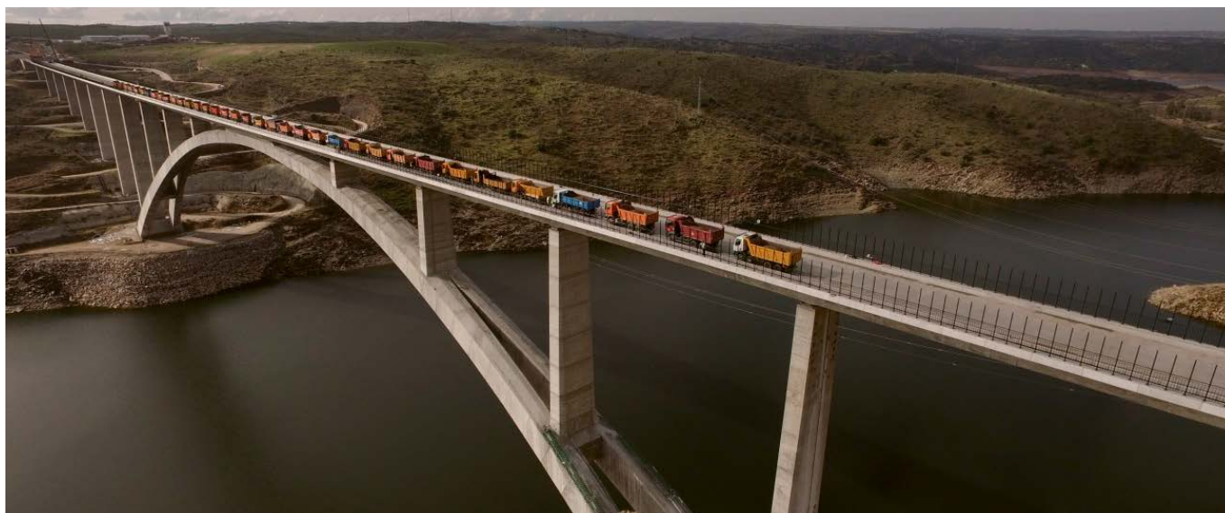
Figura 44. Posicionamiento de los camiones para la hipótesis de comprobación a torsión.
