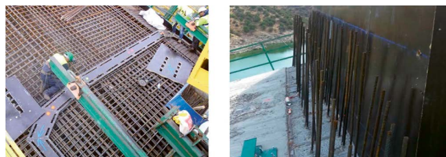
Figura 5. Plantillas de posicionamiento de manguitos de conexión de armadura de arranque de las pilastras.
