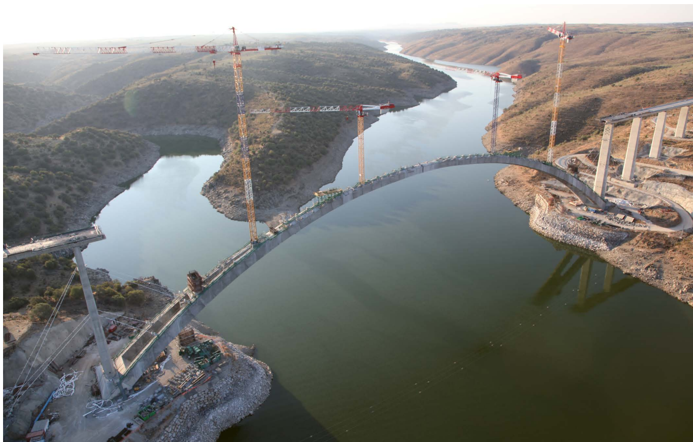
Figura 1. Imagen aérea del arco en el inicio de ejecución de las pilastras sobre el arco.
