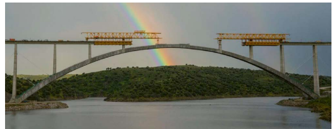
Figura 13. Fase 3 norte hormigonada y pretensada. Fase 2 sur ferrallada previo al hormigonado.
