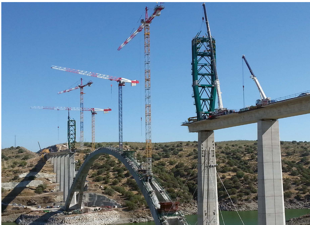
Figura 3. Inicio de la ejecución de los arranques de las pilastras sobre el arco.
