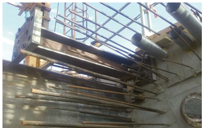
Figura 29. Puntales de bloqueo colocados entre la fase 10 y 11, en dovela de cierre norte.
