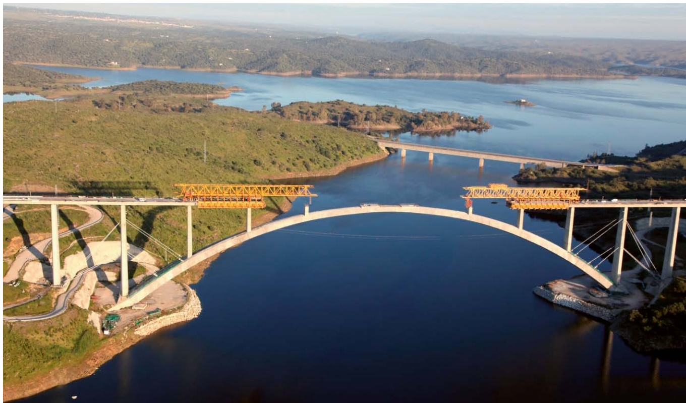
Figura 10. Fase 2 Norte Hormigonada y pretensada. Fase 2 Sur ferrallada previo al hormigonado.
