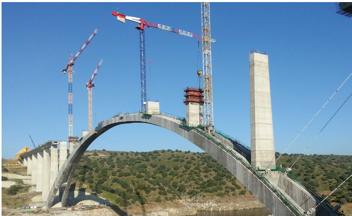
Figura 7. Hormigonado de tramo de pilastra.
