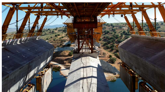
Figura 19. Avance de la autocimbra con los paneles suspendidos.
