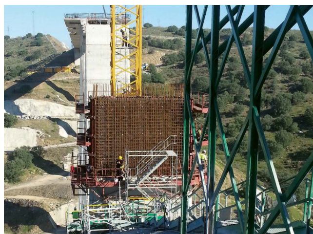
Figura 6. Tramo de armadura premontada colocado en pilastra.
