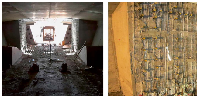
Figura 33. Vista de riostra y preparación para hormigonado en segunda fase.
