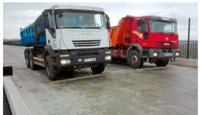
Figura 45. Posicionamiento de los camiones para prueba dinámica.
