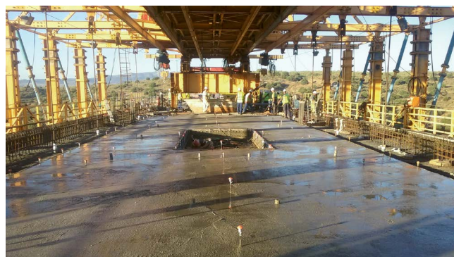
Figura 26. Hormigonado de la zona central del tablero exceptuando la zona de las alas.
