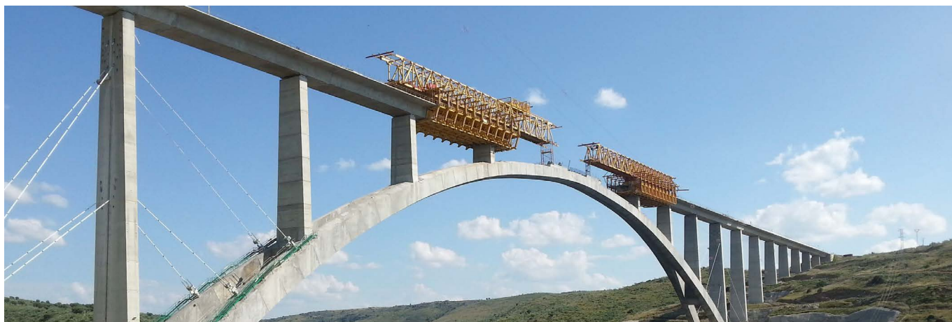
Figura 14. Interferencia en el frente de las autocimbras en las fases finales.
