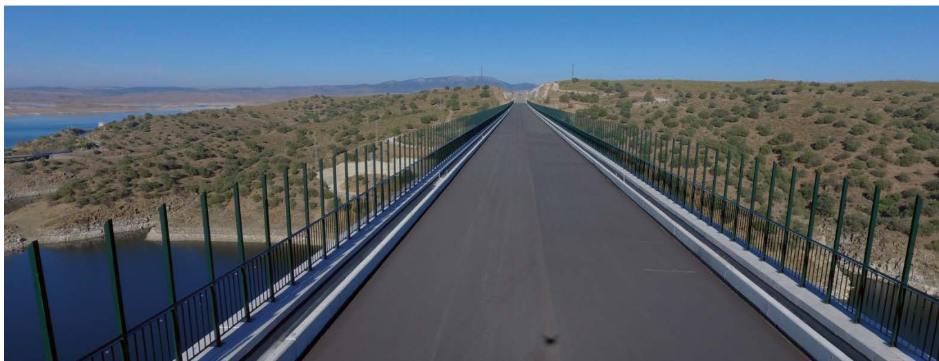
Figura 39. Barrera avifauna vista desde el interior del tablero.
