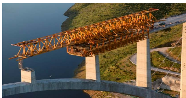
Figura 9. Imagen aérea del posicionamiento de la autocimbra para la colocación de apoyos pot.
