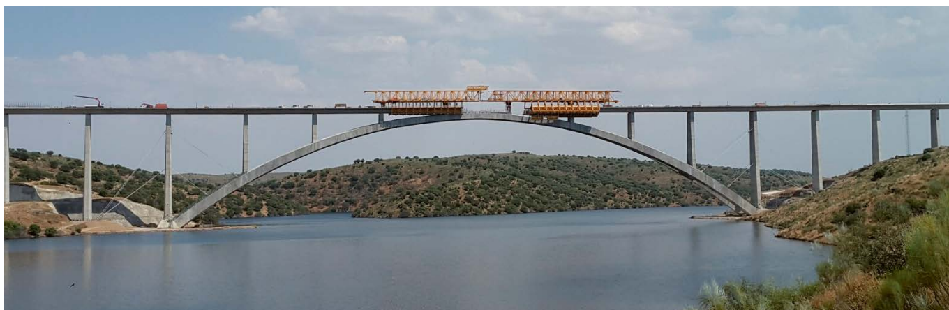
Figura 15. Autodesmontaje del frente de las autocimbras (Solución AP-Bridge).
