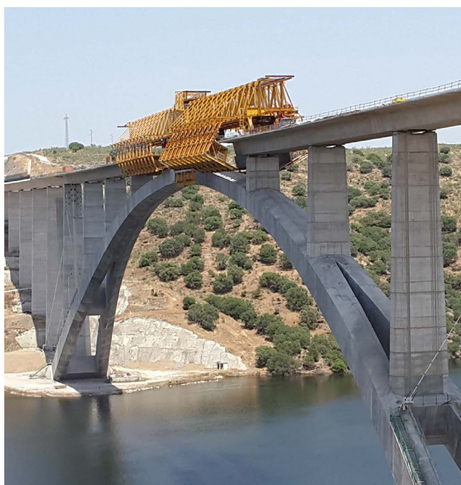
Figura 17. Cierre del encofrado en la cimbra sur.
