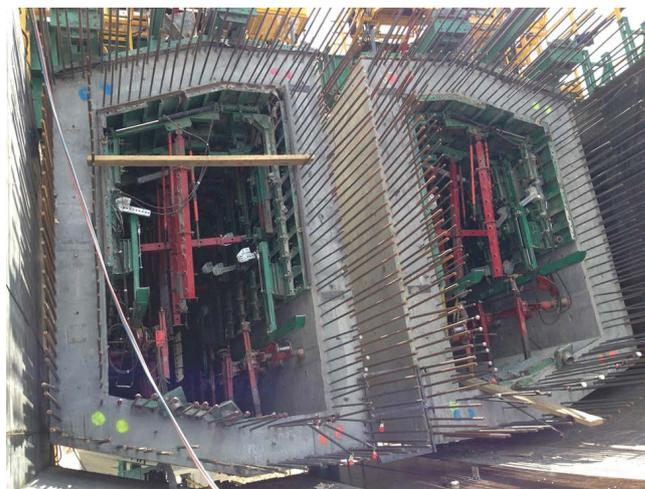
Figura 15. Detalle de paneles de encofrado interior.
