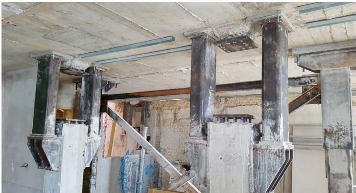
Figura 3. Edificio de la calle Diagonal 414 en Barcelona. Ménsulas y estructura auxiliar previas al descenso.
