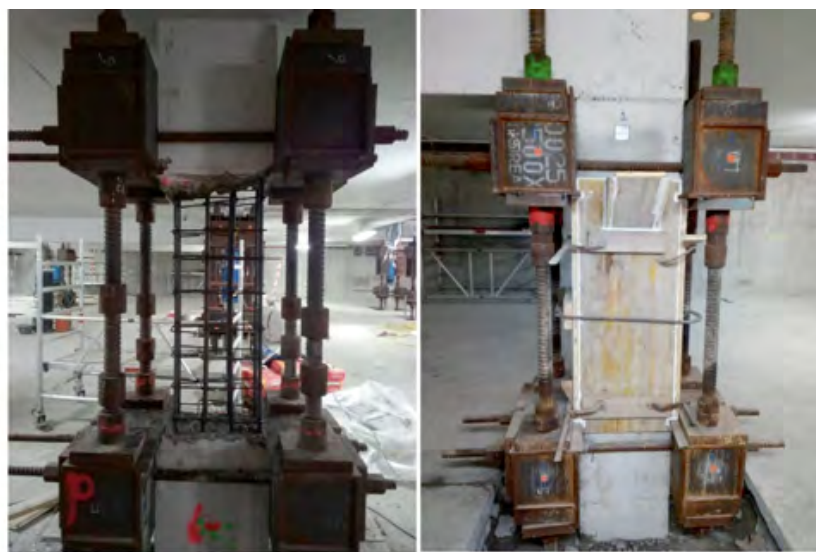
Figura 18. Restitución de soportes.
