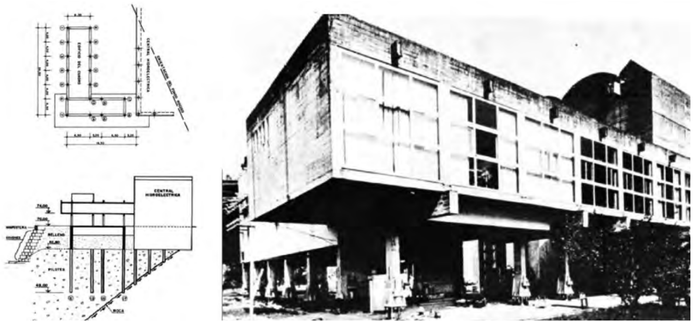
Figura 1. Elevación de edificio de Asturias 650 toneladas (MUZÁS LABAD, 1990).
