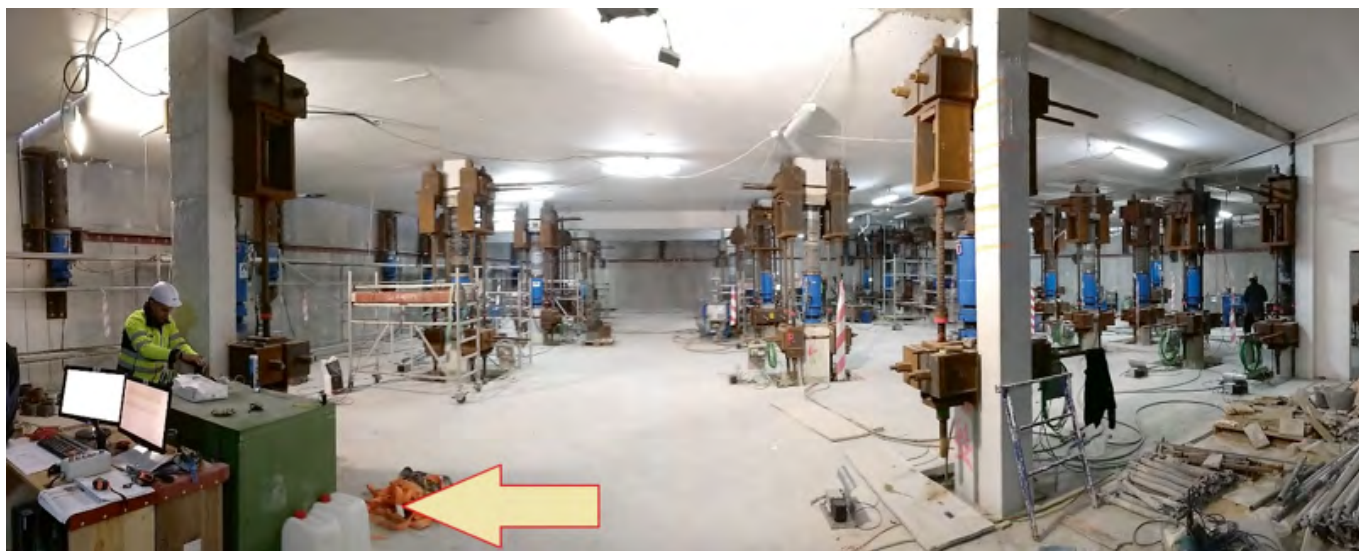
Figura 17. Maniobra. Central de sincronización de gatos.
