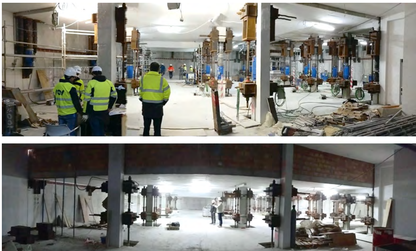
Figura 7. Descenso de edificio.
