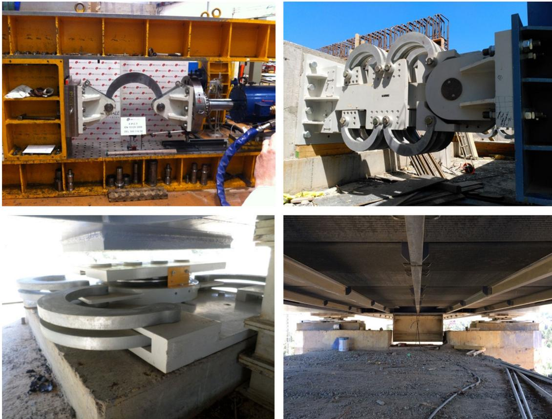
Figura 12. Imágenes de los aparatos elastoplásticos en estribos y pilas.
