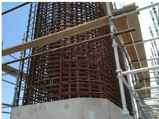
Figura 4. Detalles de armado en pila tipo.
