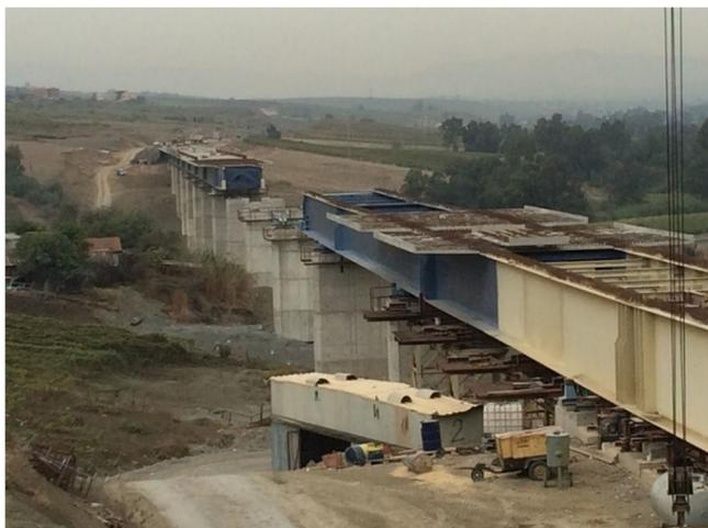
Figura 7. PK 24 empuje uno acabado y realizando empuje 2.
