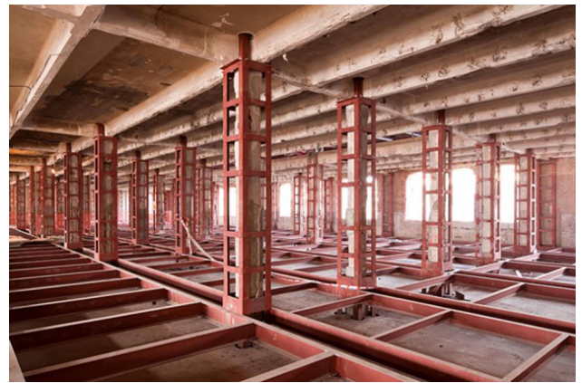
Figura 7. Nueva estructura metálica en nave 8.
