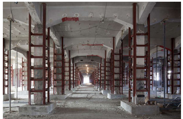
Figura 8. Nueva estructura metálica en nave 9.
