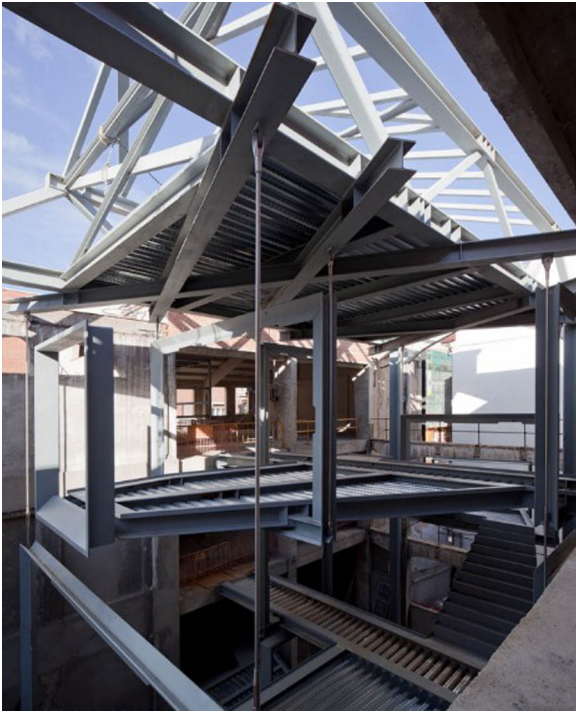
Figura 19. Vista general de la estructura metálica del núcleo de comunicación durante el proceso constructivo.
