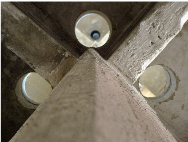
Figura 5. Huevo para paso de los nuevos pilares a través de las losas existentes.
