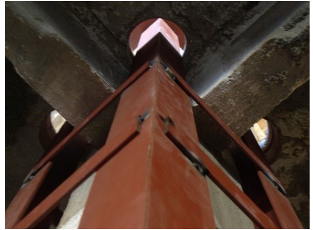
Figura 6. Pilares ya ejecutados pasando a través del forjado.
