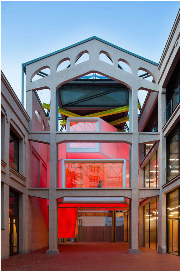
Figura 20. Vista de la nueva estructura metálica desde el patio.
