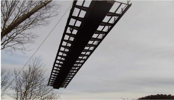
Figura 24. Izado del vano central.
