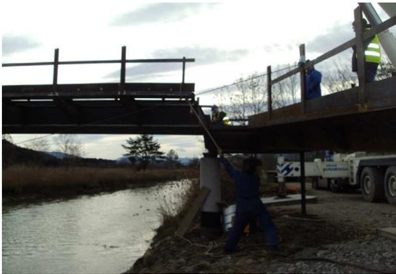
Figura 25. Colocación del vano central.
