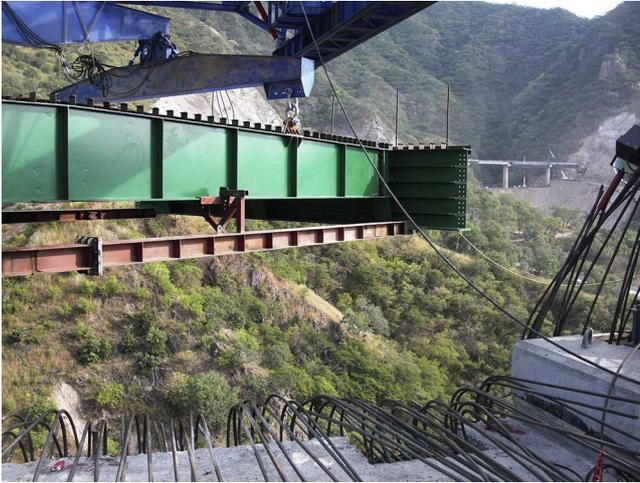
Figura 18. Dóvela con escantillón, orejetas y balancines.
