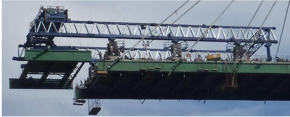
Figura 16. Disposición de apoyos de lanzadora sobre tablero.
