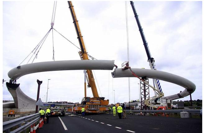
Figura 18. Colocación del cuarto tramo metálico mediante grúa en estribo 1 [1].
