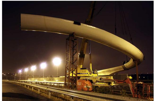
Figura 17. Colocación del tercer tramo metálico en estribo 2 [1].
