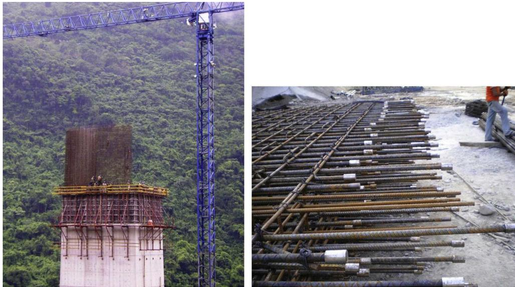
Figura 24. Premontaje de la armadura de las pilas.
