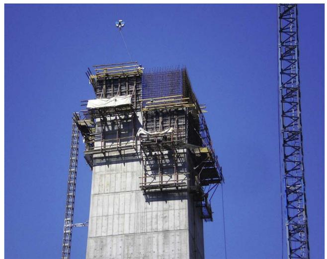
Figura 25. Encofrado trepante convencional en pilas 2, 3 y 5.
