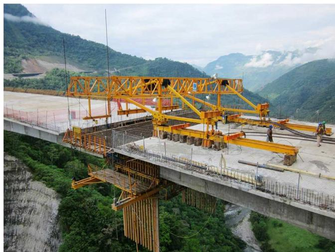
Figura 30. Cierre de un vano central.
