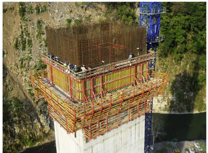
Figura 26. Encofrado autotrepante en pila 4.
