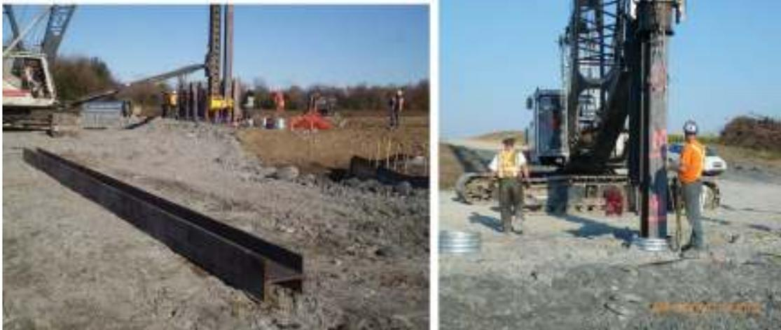
Figura 15. Hincia de pilotes metálicos.
