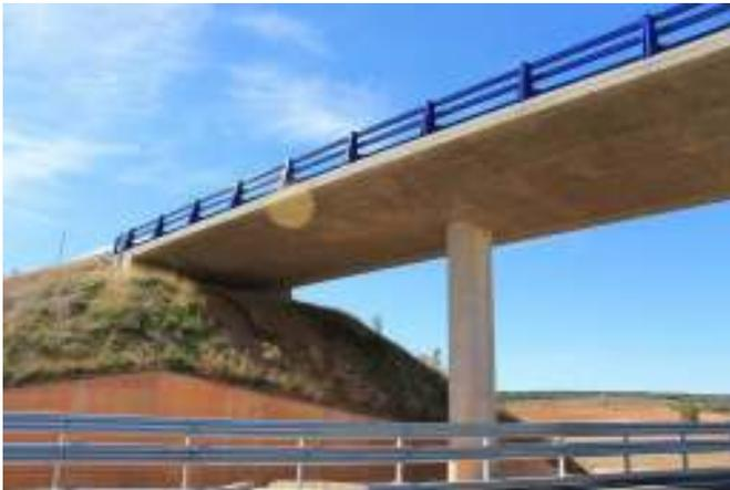
Figura 20. Pilas empotradas en Ossa de Montiel.
