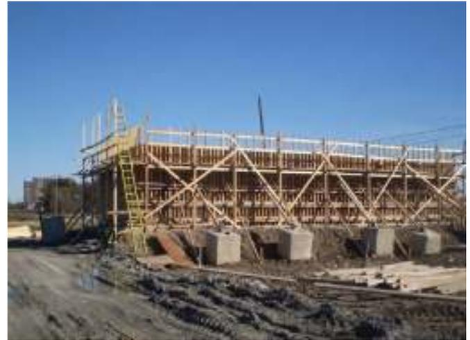
Figura 4. Encofrado de estribo este W12.
