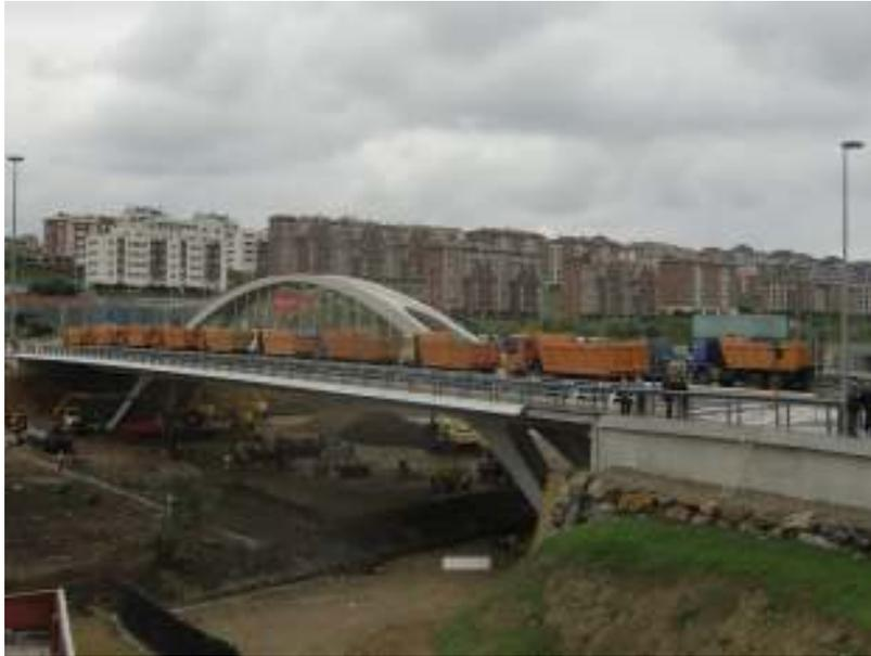
Figura 19. Vista de la realización de la prueba de carga.
