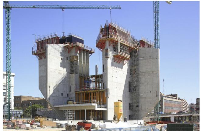
Figura 16. Encofrado trepante.
