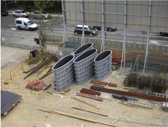
Figura 11. Encofrado metálico del pilar fusiforme.
