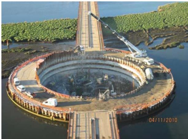
Figura 8. Excavación del interior del recinto de P-5.
