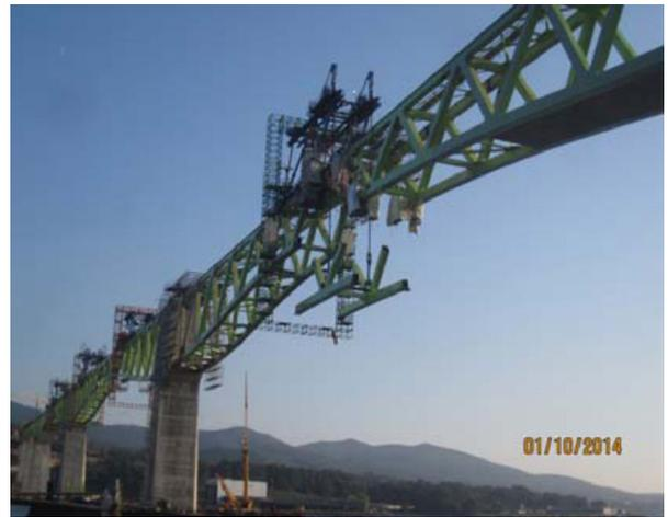
Figura 43. Izado de dovela de cierre del vano 8.
