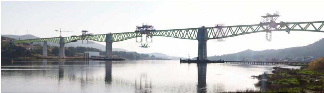
Figura 44. Izado de dovela de cierre del vano 7.
