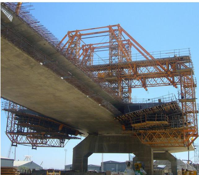
Figura 10. Voladizos exteriores ejecutados con carro.
