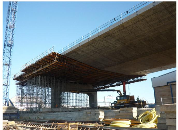
Figura 4. Descimbrando en fase de ejecución.
