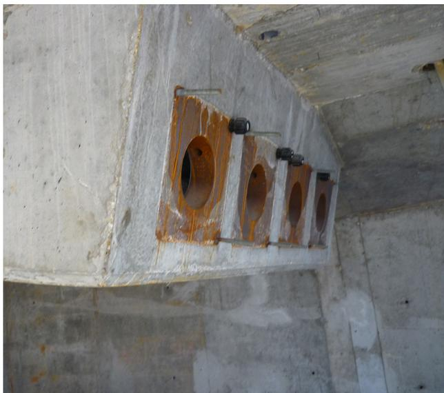
Figura 12. Anclajes pretensado en segunda fase.
